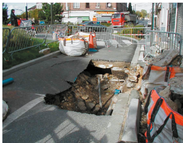
Photographie 8 : effondrement observé sur la commune de Villeteuse en lien avec la fuite du réseau d'assainissement (source : Cerema, juillet/octobre 2004)
