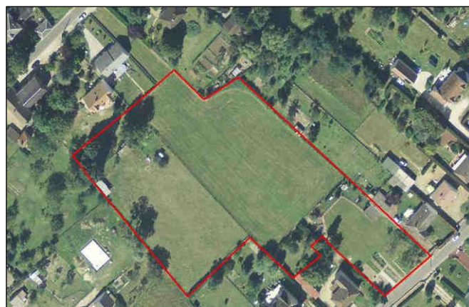
Vue aérienne de la zone d'extension du Clos du Huchet
