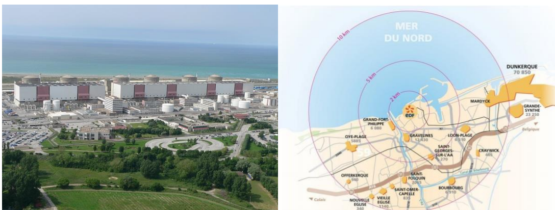
Centrale de Gravelines- Source : EDF
