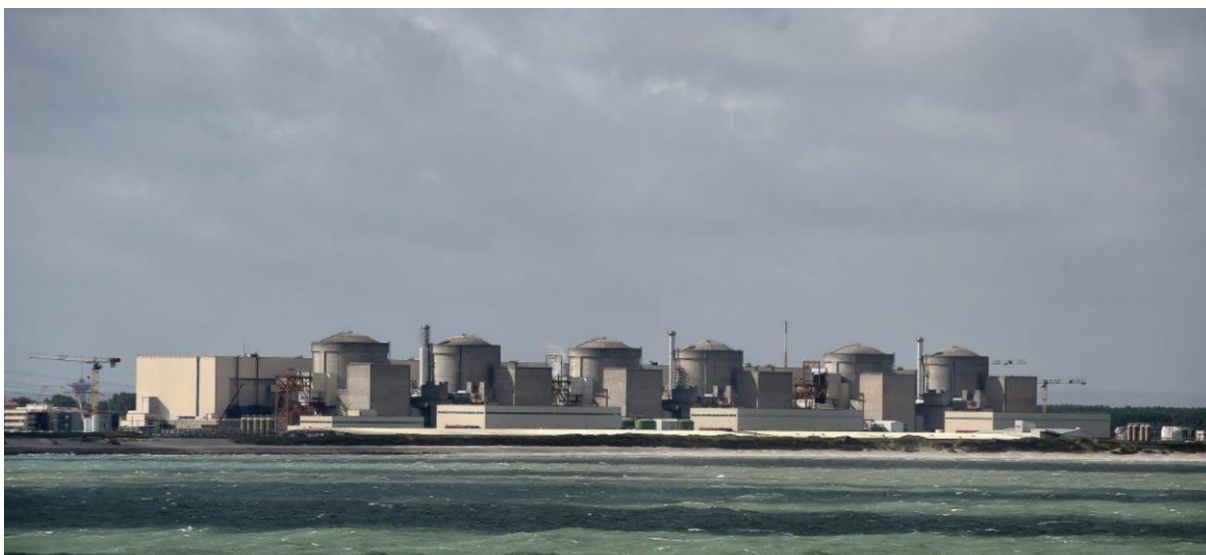
Centrale nucléaire de Gravelines, Source : hauts-de-france.developpement-durable.gouv.fr
