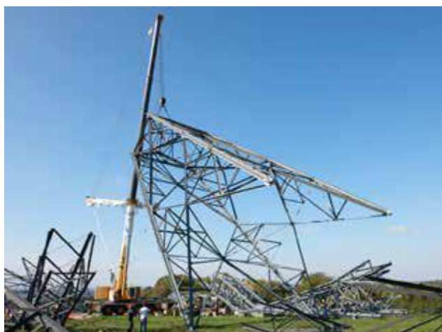
Figure 9. Exemple de dépose d'un pylône à la grue
