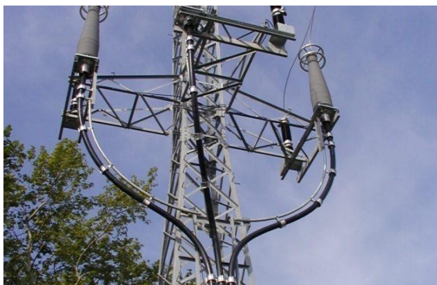
Figure 6. Fourreaux PEHD en pleine terre et exemple d'extrémités sur un pylône aérosouterrain 90 000 volts (Source : RTE)
