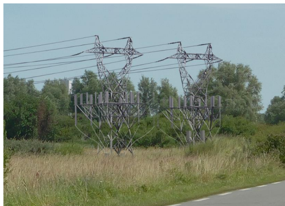
Figure 8. Exemple de pylône aérosouterrain 225 000 volts
