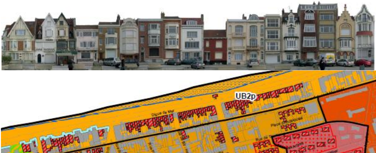
Secteur balnéaire de Malo-les-bains : un important inventaire du patrimoine pour préserver les caractéristiques des constructions du bord de mer
