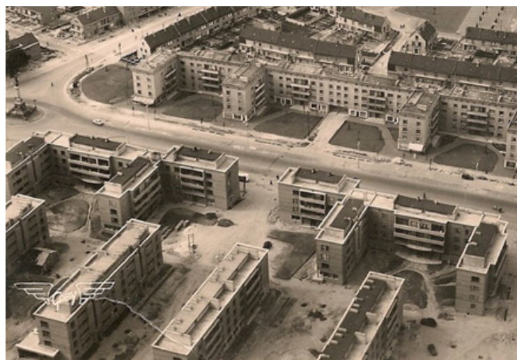
Le groupe Pont Carnot en cour de construction
