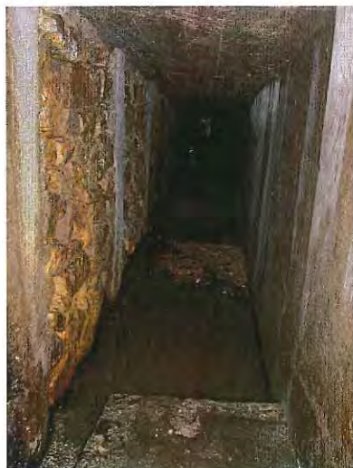
Ancienne galerie drainante Ouest
