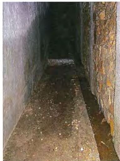
Ancienne galerie drainante Est
