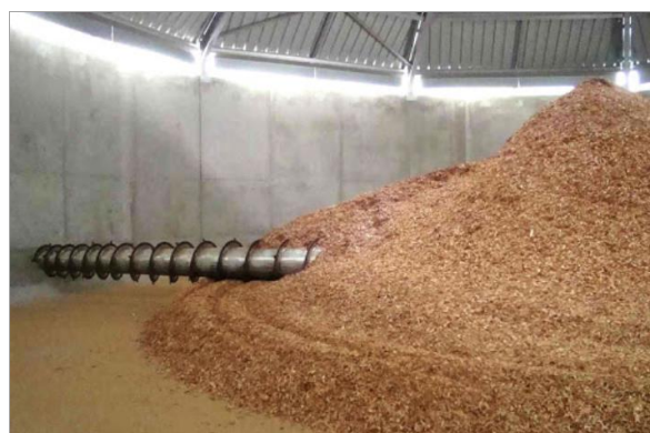
Le développement des réseaux de chaleurs alimentés par des chaudières collectives utilisant des plaquettes bocagères conforte la filière locale
