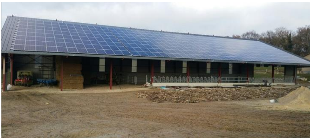
Hangar agricole avec toiture photovoltaïque
