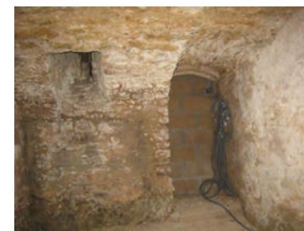
Photo 1: Accès muré du souterrain dans la cave de la mairie (Ind. 005)
