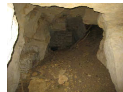
Photo 6: Cavité obstruée par des effondrements (Ind. 097)
