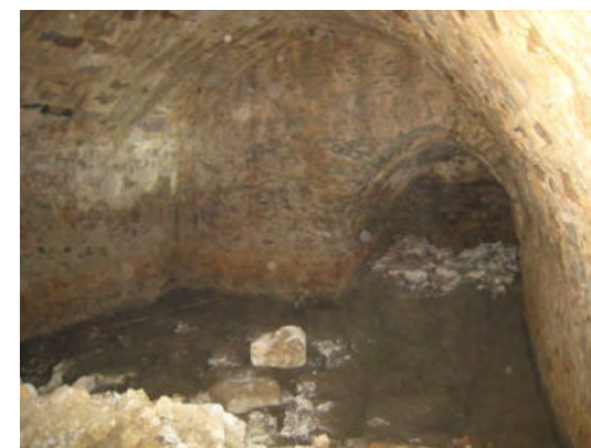
Photo 1: Cave voûtée maçonnée au lieu-dit "Biette", Ind. 015
