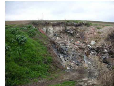
Photo 4: Indice 002, entrée de cavité comblée par des matériaux divers
