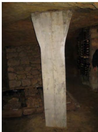
Photo 3: Pilier en béton sous le croisement de la rue de la Chapelle et de la rue ancienne des Halles (Ind. 024)
