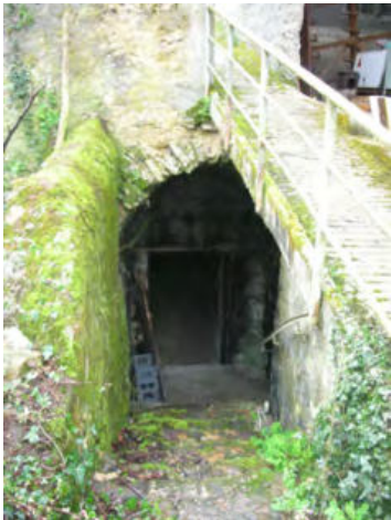
Photo 1: Ind. 018, descenterie permettant l'accès à une cave
