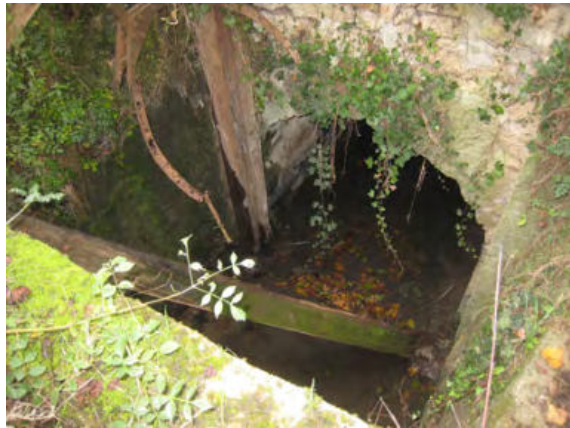
Photo 2: Départ de l'ouvrage hydraulique aux abords du moulin (Ind. 006)
