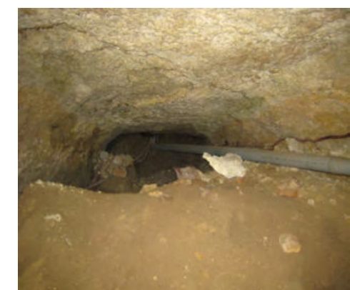
Photo 2: "La Pidoucière", extrémité de cave donnant sur un effondrement comblé, Ind. 016
