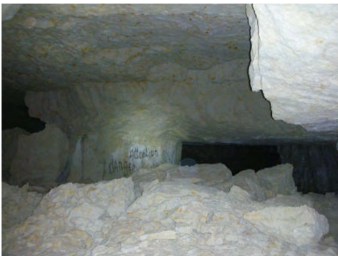
Photo 6: Ind. 028, voûte effondrée sur une surface importante
