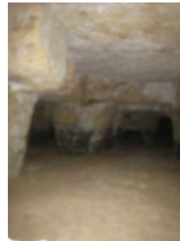
Photo 4: Vue de la carrière (chambres et piliers) au niveau du lieu-dit les Herveaux
