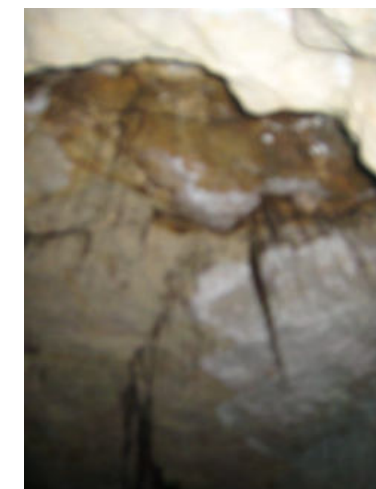
Photo 5: Cloche de fontis en formation dans une poche argileuse au niveau du lieu-dit les Herveaux
