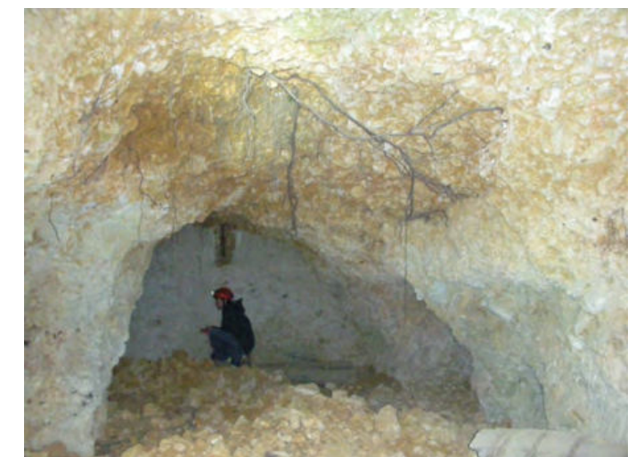
Photo 2: Indice 005, cavité en mauvais état
