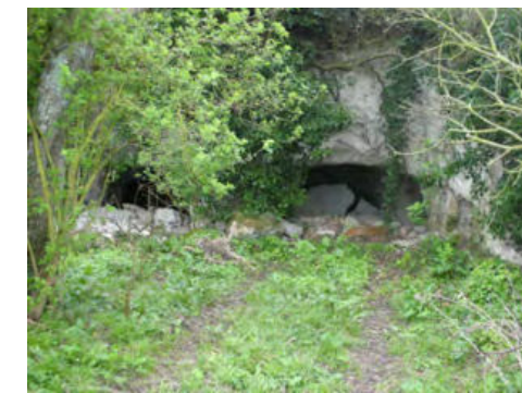
Photo 5: Indice 003, chute de blocs visibles en entrée de la carrière
