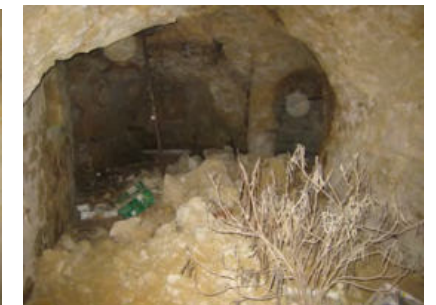
Photo 5: Chutes de ciels dans une cavité avec départs de galeries murées (Ind. 093)
