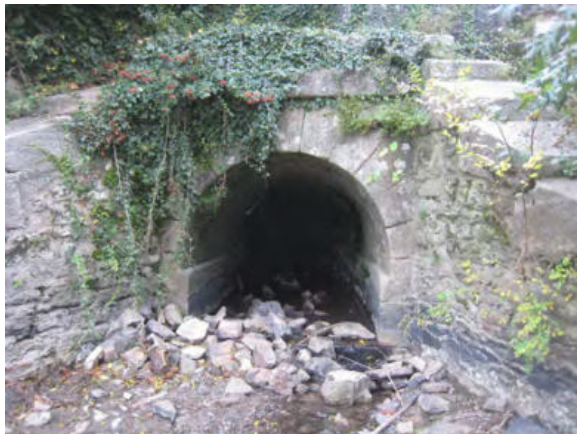
Photo 3: Ouvrage hydraulique proche du moulin (Ind. 007)
