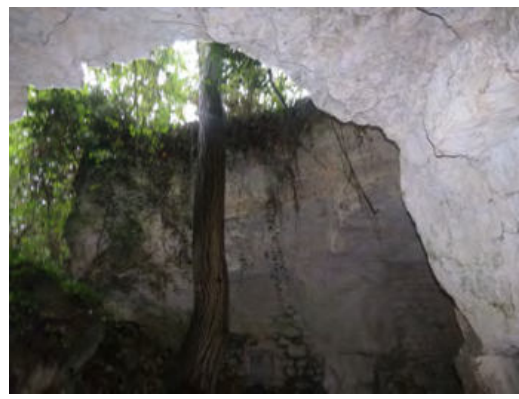
Photo 3: Effondrement, secteur de La Périchère
