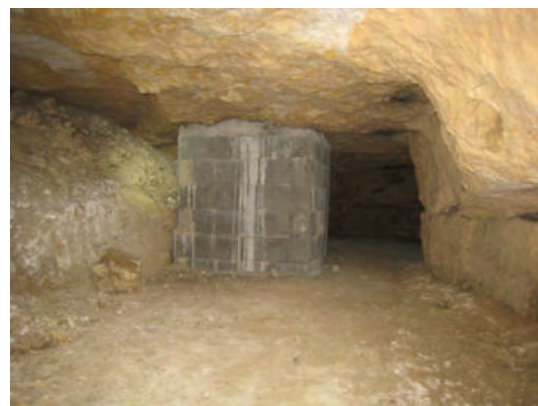
Photo 2: Pilier créé sous la rue de la Chapelle (Ind. 025)
