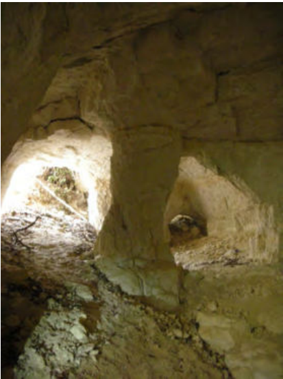
Photo 3: Ind. 020, pilier fracturé
