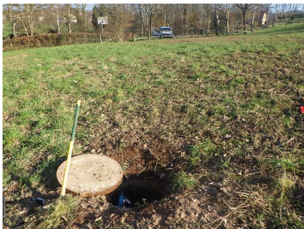
SYR3 - sonde piézométrique + seuil normalisé - Vue extérieure
