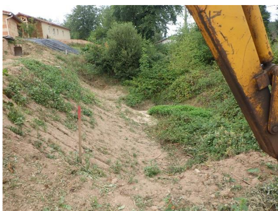
Bassin de rétention du lotissement du soleil du Mont Louis – vue 1
