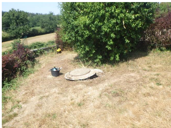
Cadre non scellé – réseau d'eaux usées – chez un particulier le long de la RD 201 – R59
