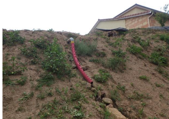
Bassin de rétention du lotissement du soleil du Mont Louis – vue 2
