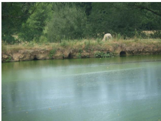
Berges du deuxième bassin détériorée par les ragodins
