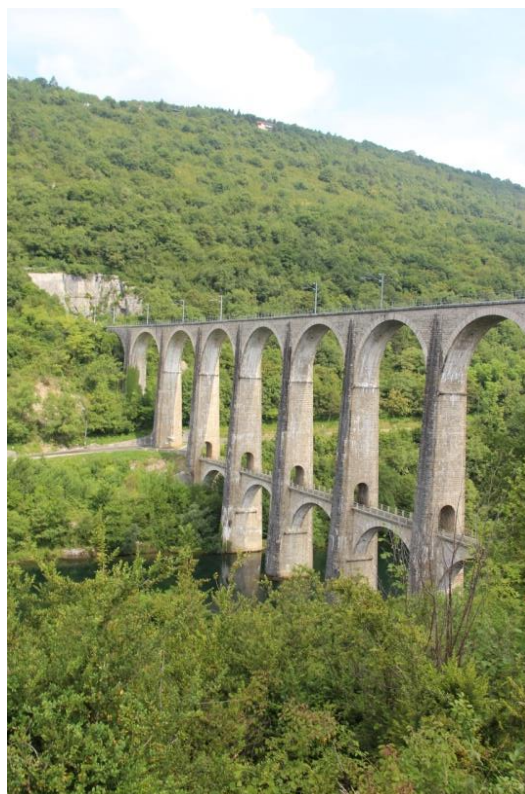
Photo G-35 Viaduc de Cize-Bolozon
