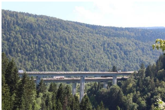
Photo G-5 Les viaducs de l'autoroute des Titans
