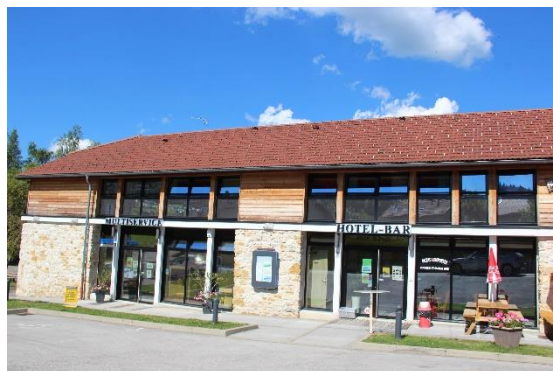
Photo G-19 : scierie réhabilitée à Charix
