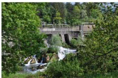
Photo E.4 Le barrage d’Intriat ou barrage des Tablettes
