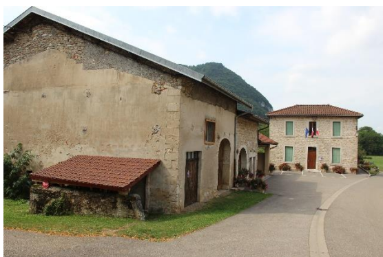
Photo G-16 : Bâtisse agricole avec en arrière-plan la mairie de Bolozon
