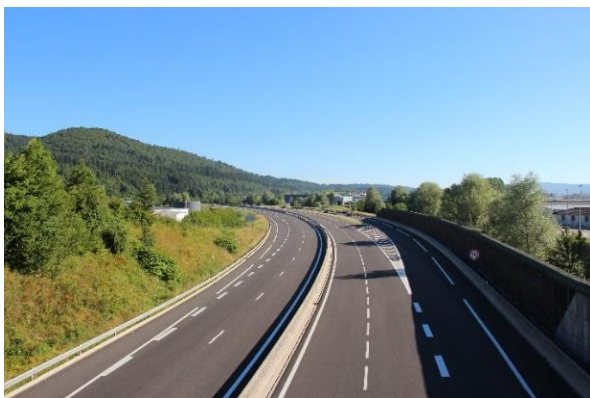
Photo G-13 L'autoroute A404 à hauteur de Groissiat
