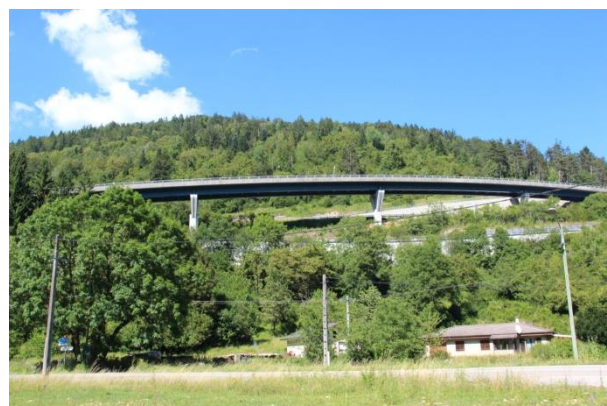
Photo G-37 Viaducs de l'autoroute des Titans
