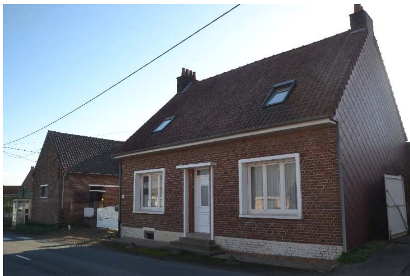
Figure 15 Vue d'ensemble, au premier plan le logis
