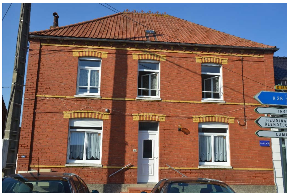
Figure 106 Vue de la façade
