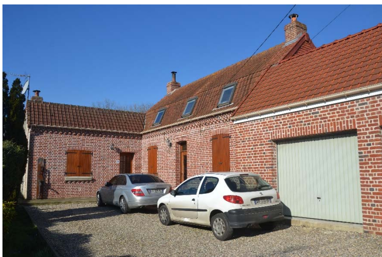
Figure 96 Vue générale du corps de bâtiments
