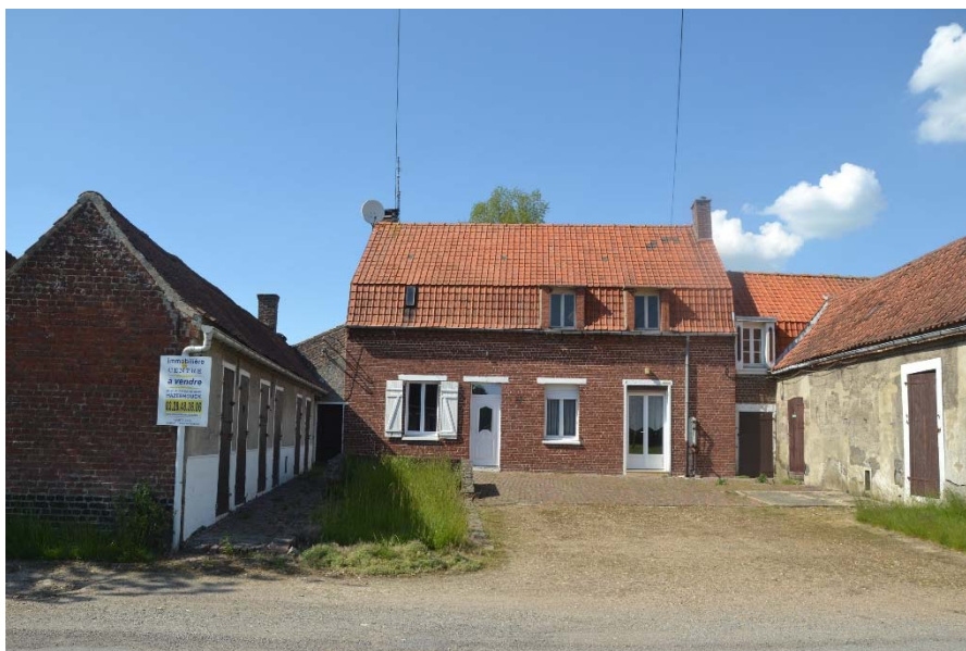
Figure 135 Vue générale avec logis et dépendances
