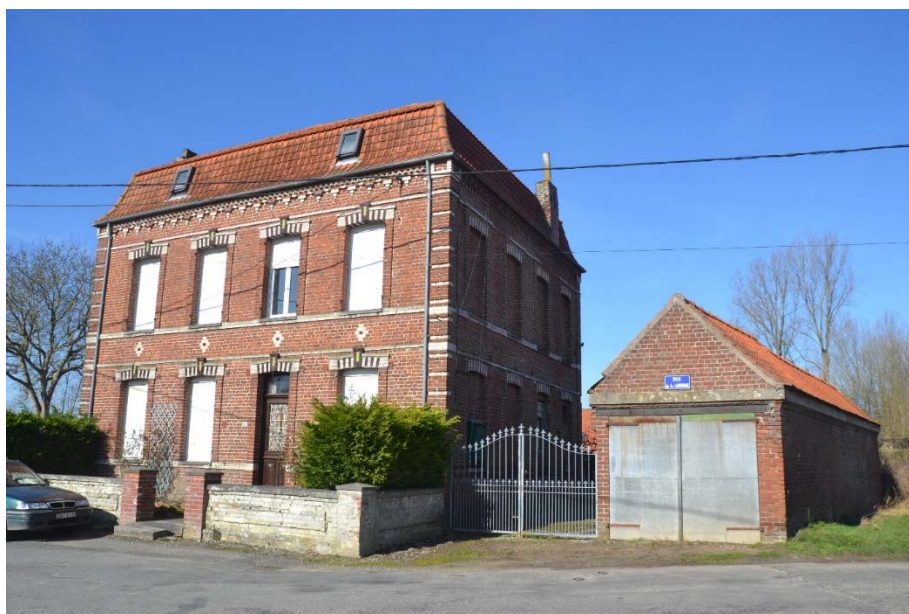
Figure 38 Vue générale du bâtiment
