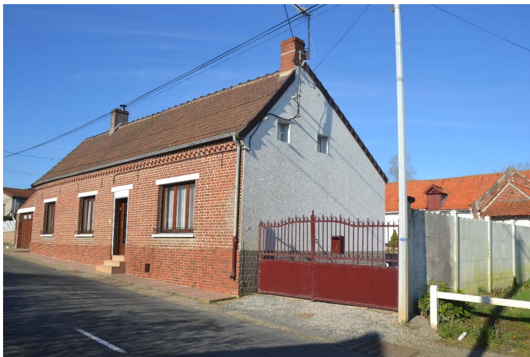
Figure 23 Vue d'ensemble avec logis en bordure de voie et dépendances en fond de cour
