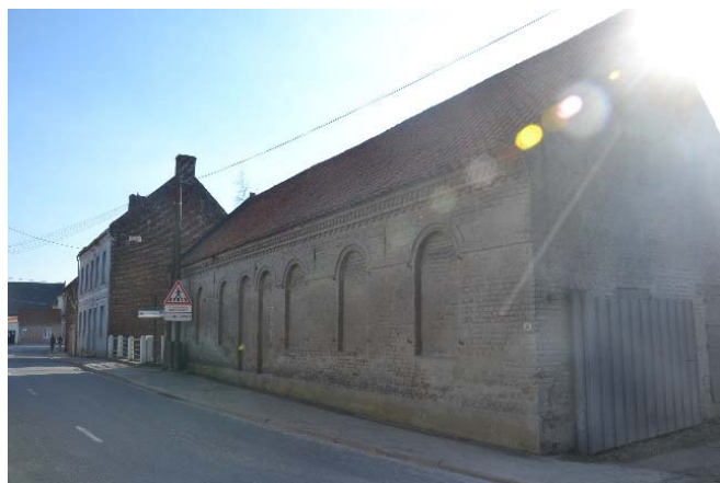
Figure 102 Vue de la dépendance
