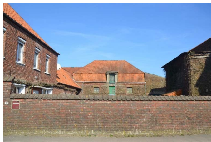
Figure 5 Vue d'ensemble, à gauche de l'image le logis, au centre la malterie
