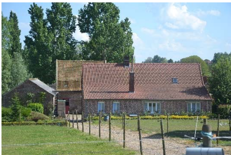
Figure 120 Vue générale du corps de ferme
