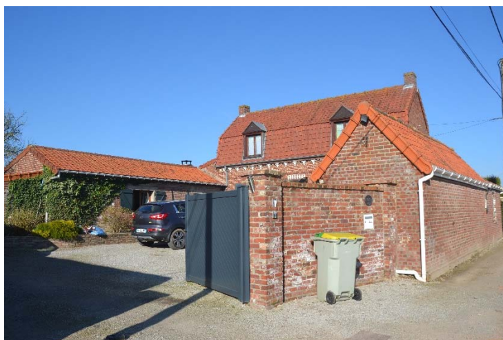
Figure 92 Vue du corps de ferme
