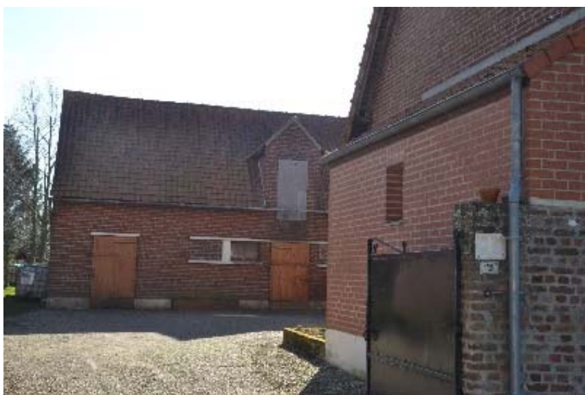
Figure 40 Vue des dépendances depuis la voie
