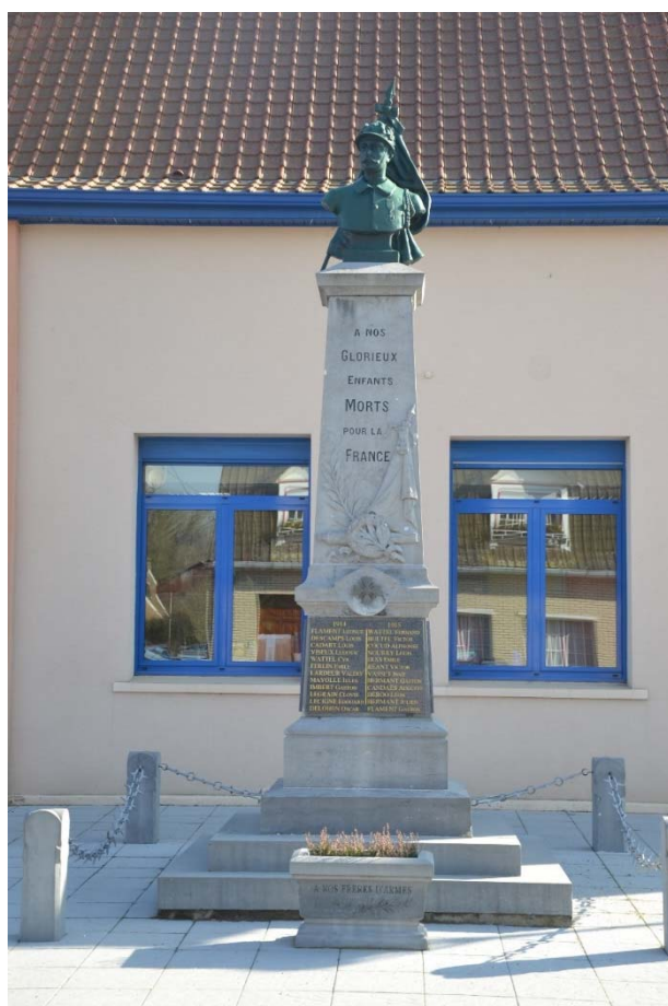
Figure 105 Vue du monument aux morts
