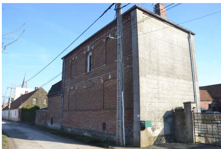
Figure 110 Vue générale du bâtiment
