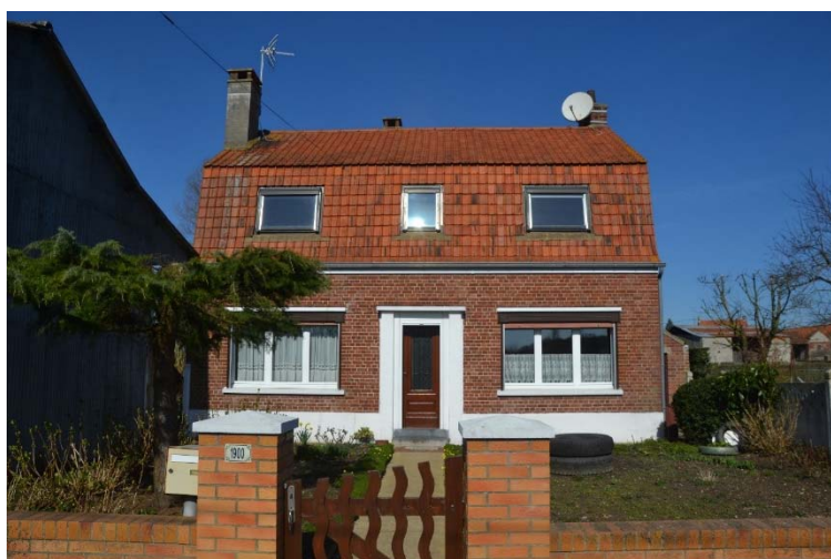
Figure 50 Vue de la façade du logis
