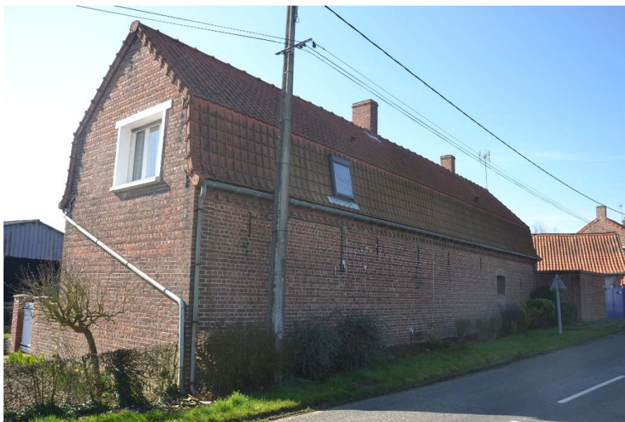
Figure 44 Vue d'ensemble du bâtiment
