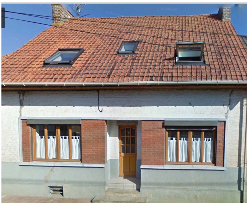
Figure 137 Vue de la façade du logis
