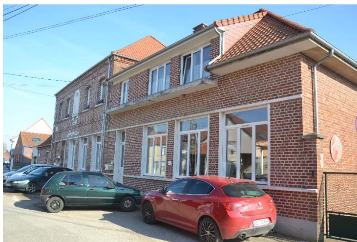
Figure 107 Vue générale du corps de bâtiments
