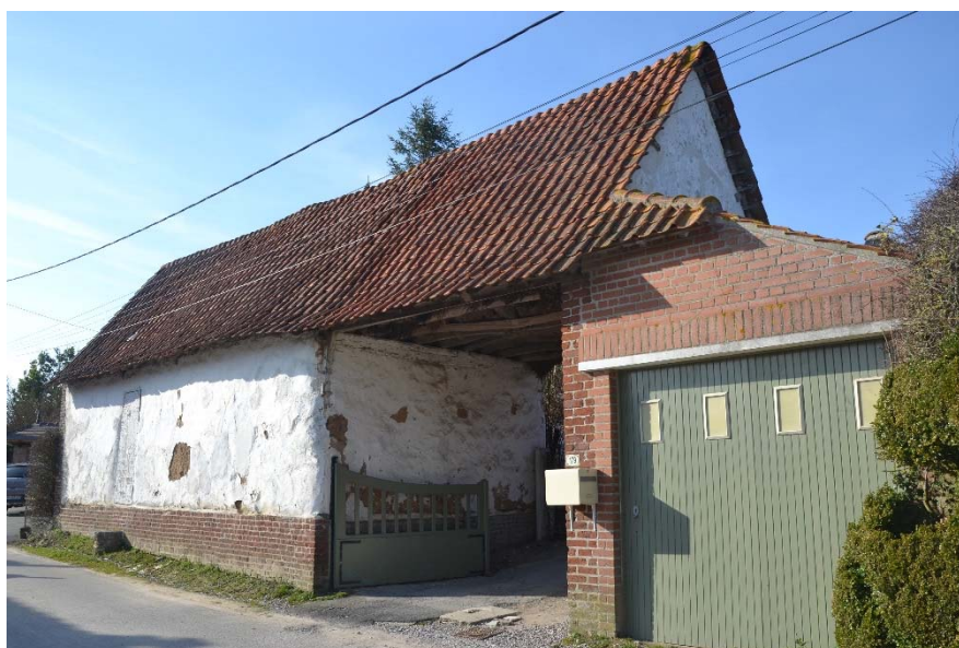
Figure 112 Vue générale de la dépendance
