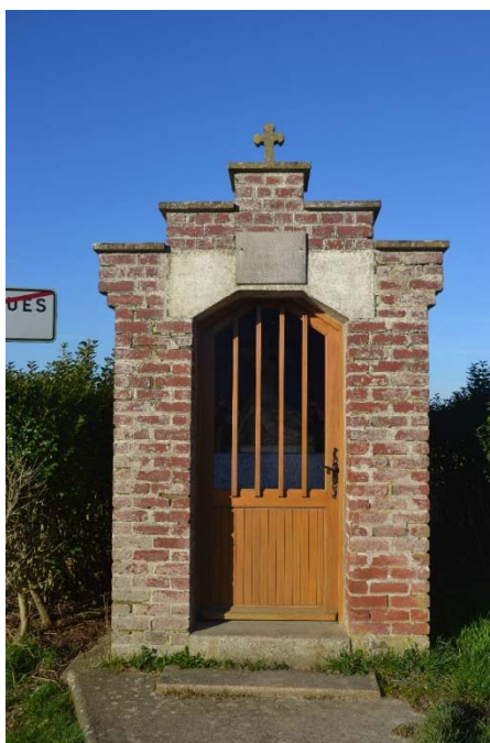
Figure 6 Façade de la chapelle
