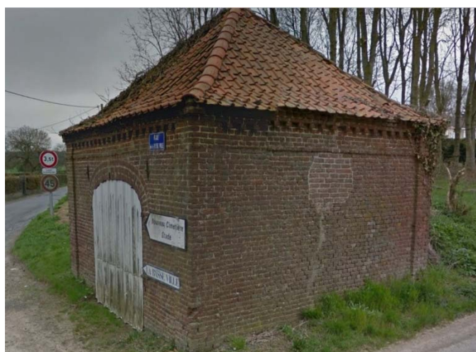
Figure 27 Vue du bâtiment
