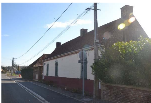
Figure 31 Vue d'ensemble du bâtiment
