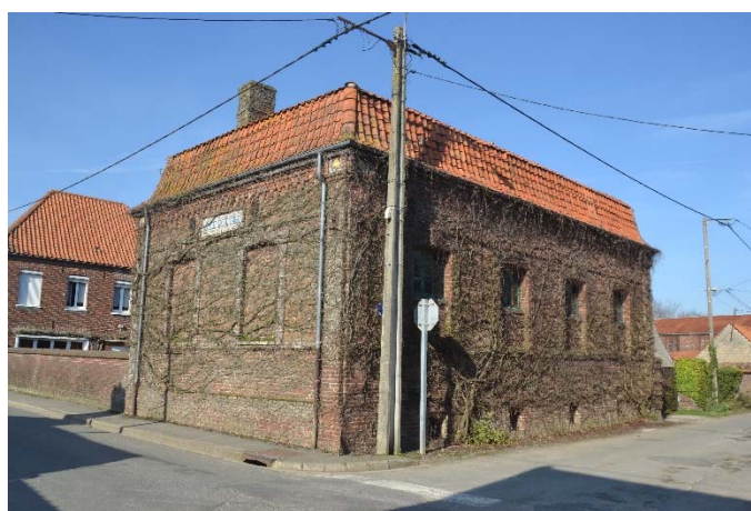
Figure 4 Vue d'ensemble, au premier plan la brasserie
