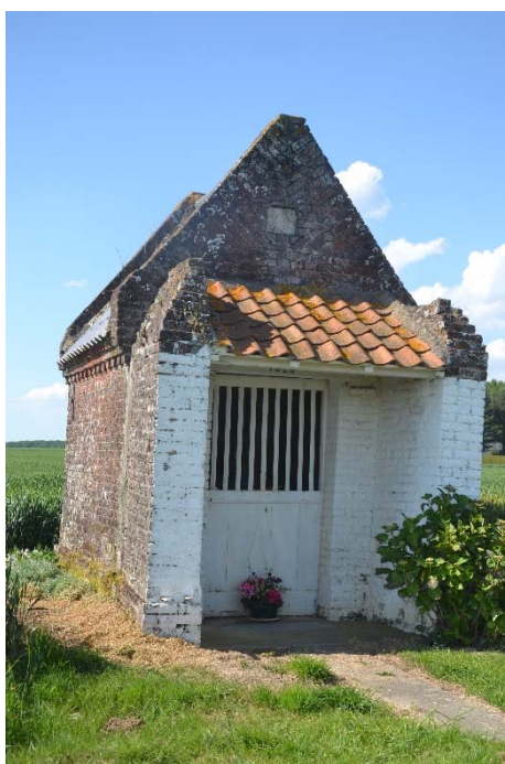
Figure 62 Vue générale de la chapelle
