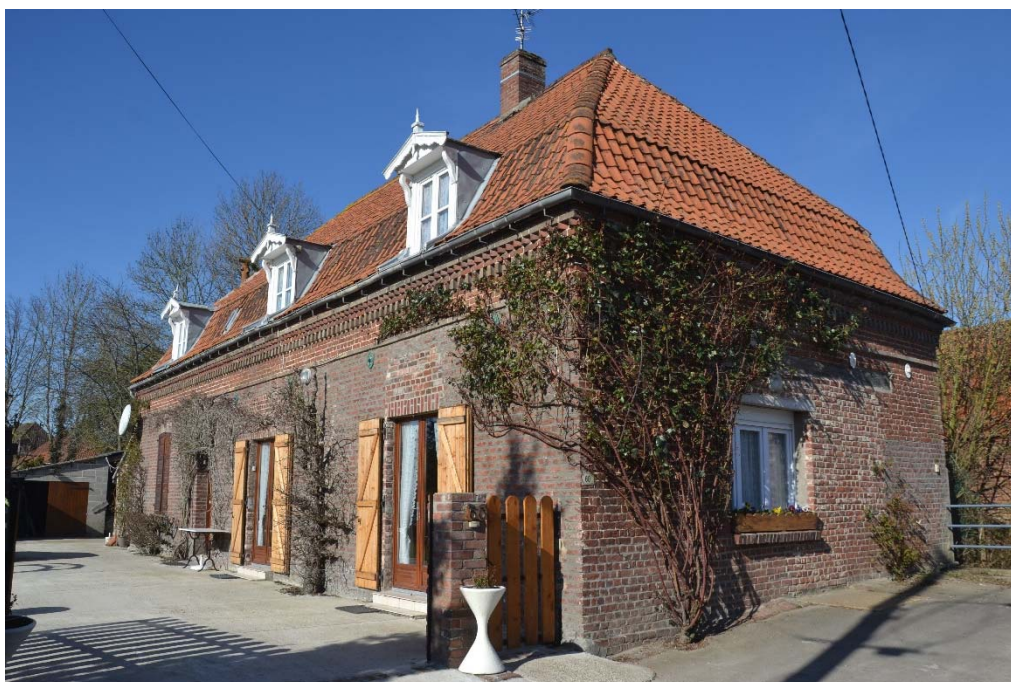
Figure 34 Vue générale du bâtiment
