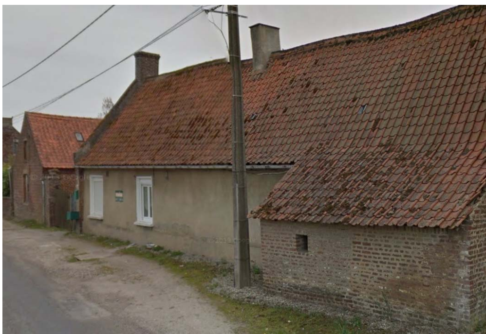
Figure 122 Vue générale du bâtiment
