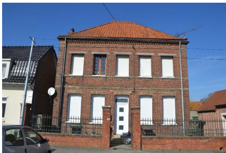
Figure 59 Vue de la façade du bâtiment
