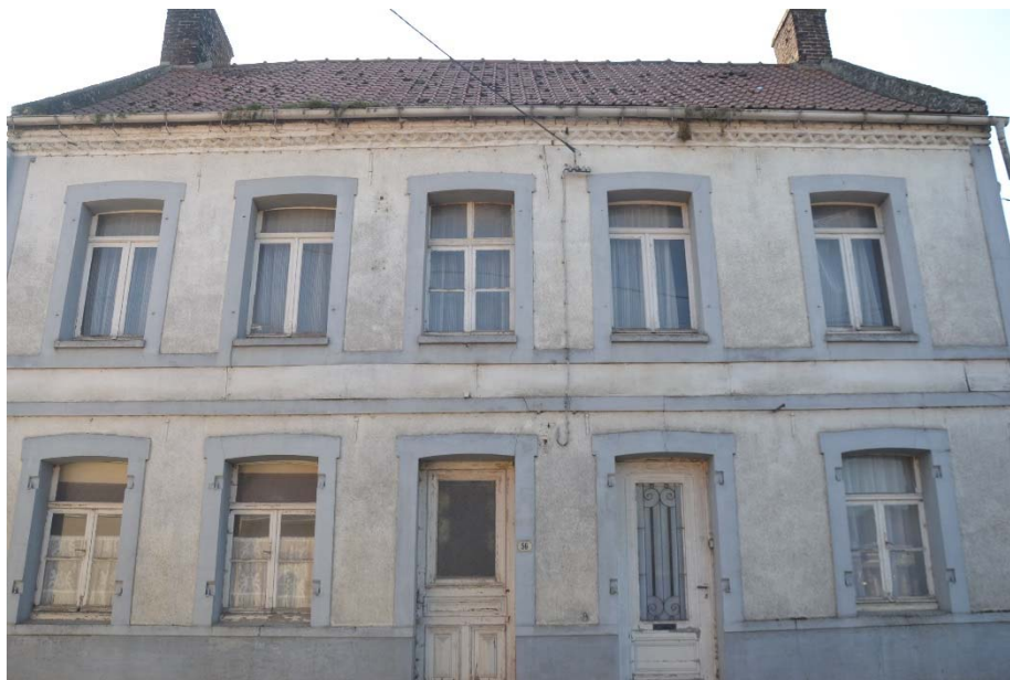
Figure 141 Vue de la façade depuis la voie
