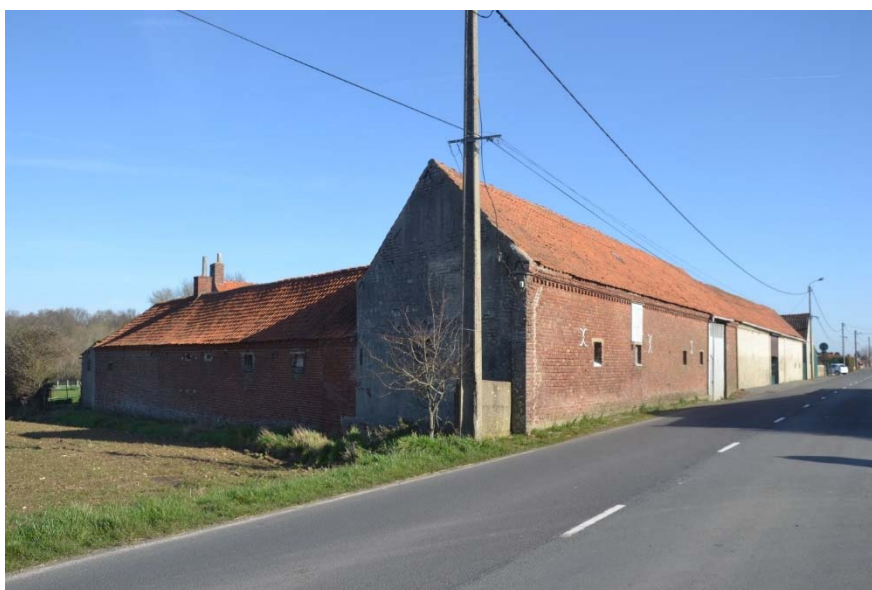
Figure 24 Vue d'ensemble du corps de bâtiments
