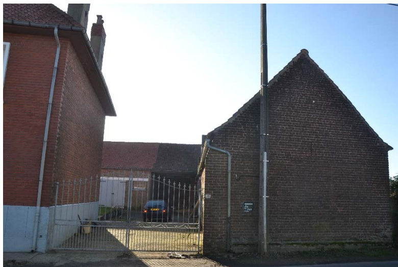
Figure 12 Vue des dépendances depuis la voie
