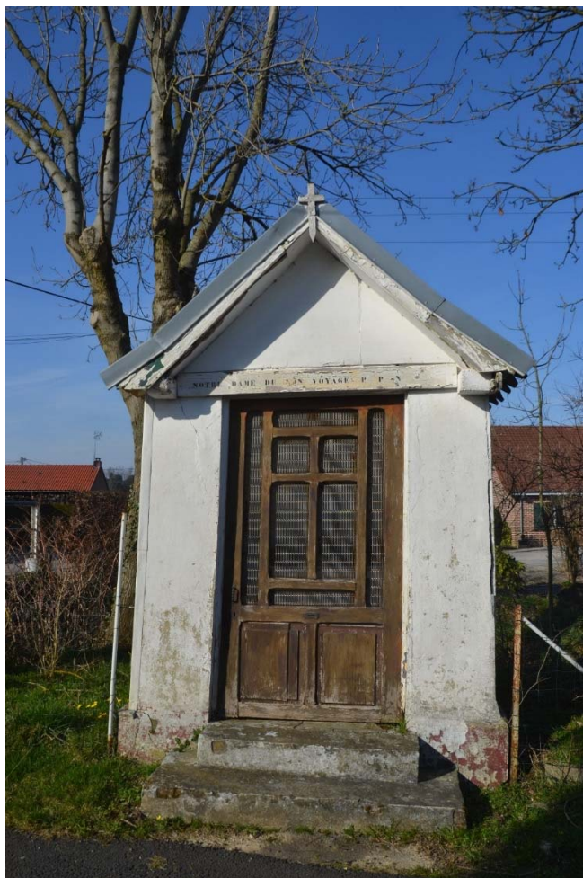
Figure 114 Vue de la chapelle
