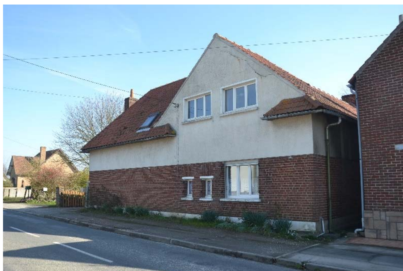
Figure 66 Vue de la façade du logis
