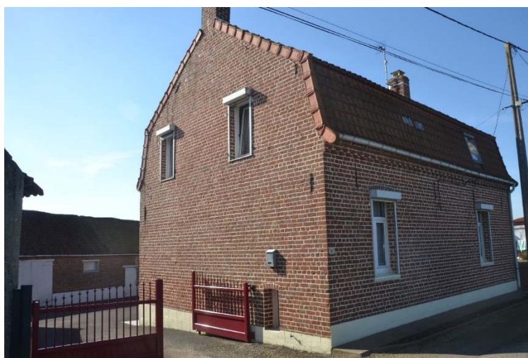
Figure 43 Vue générale du corps de ferme
