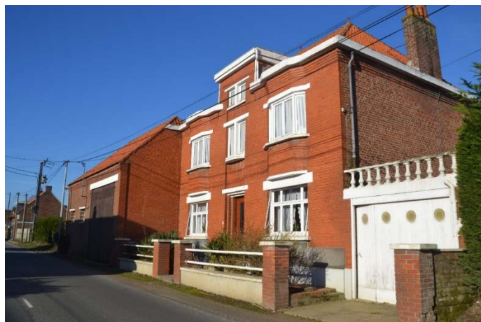
Figure 9 Vue d'ensemble du site
