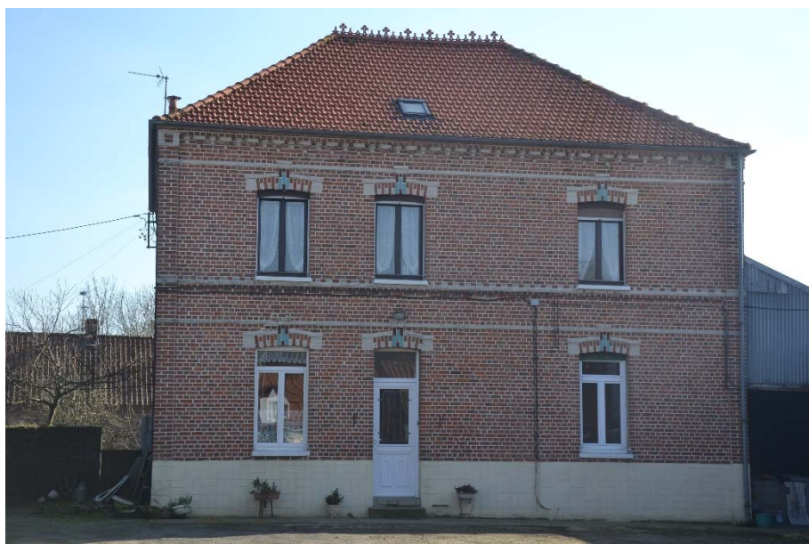
Figure 101 Vue de la façade du logis
