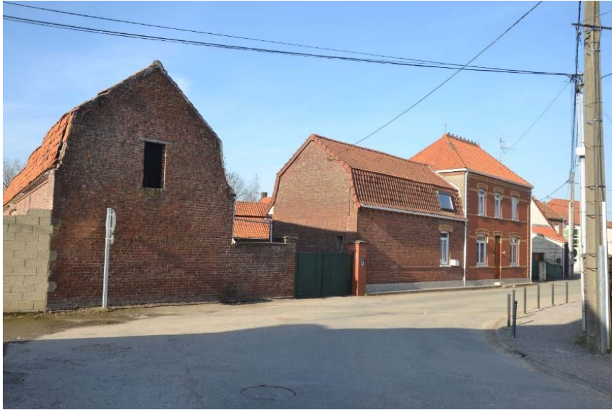
Figure 108 Vue générale du corps de ferme
