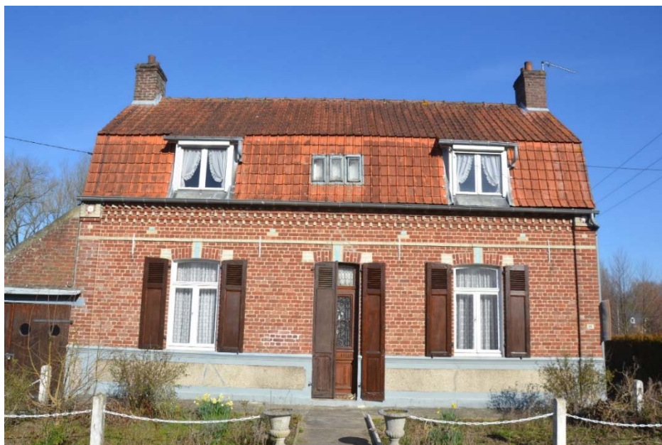
Figure 30 Vue de la façade
