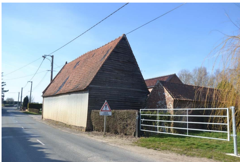
Figure 100 Vue de la dépendance
