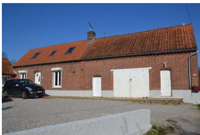
Figure 97 Vue générale des bâtiments
