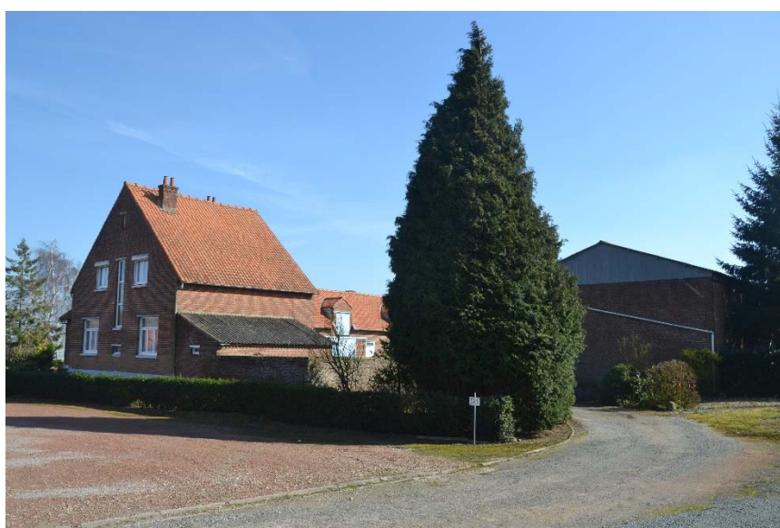
Figure 68 Vue générale du corps de ferme
