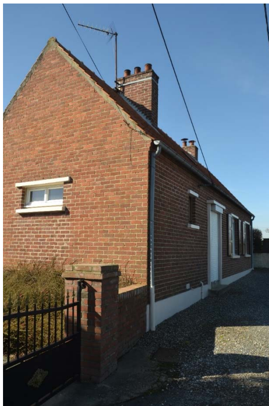
Figure 45 Vue générale du bâtiment
