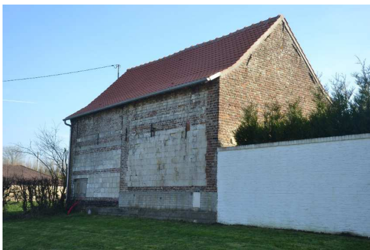
Figure 4 Vue de la dépendance
