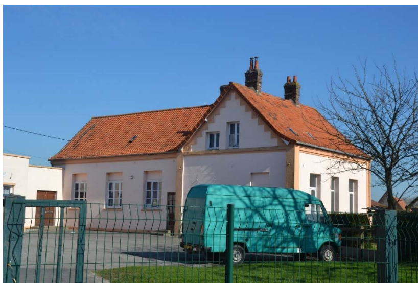
Figure 58 Vue générale du bâtiment
