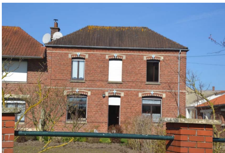
Figure 52 Vue du logis n°1990
