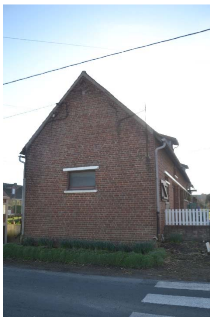
Figure 16 Vue des dépendances depuis la voie
