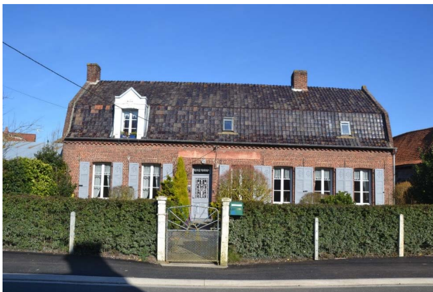
Figure 33 Vue de la façade du logis
