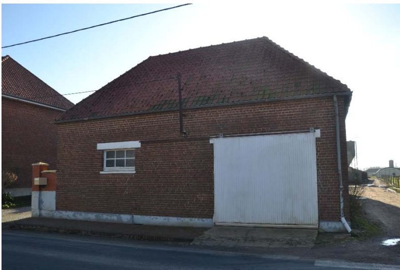
Figure 20 Vue du corps de dépendances face à la voie
