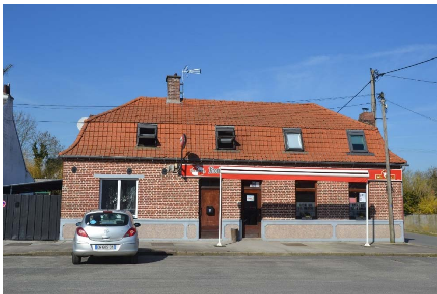
Figure 61 Vue de la façade du bâtiment
