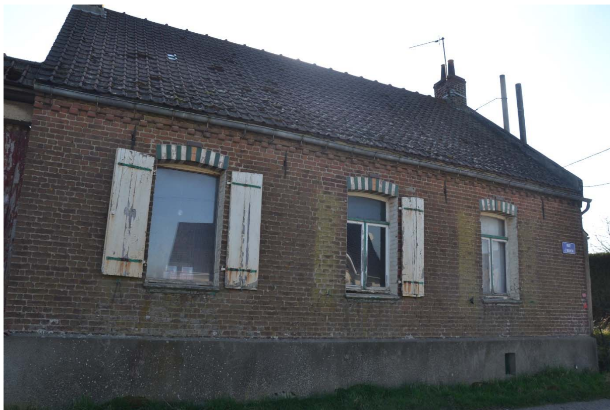
Figure 116 Vue de la façade du logis
