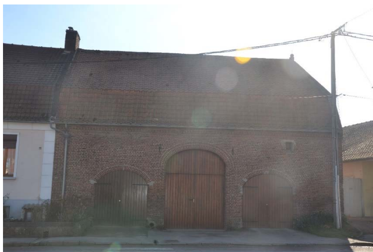
Figure 60 Vue de la façade du bâtiment
