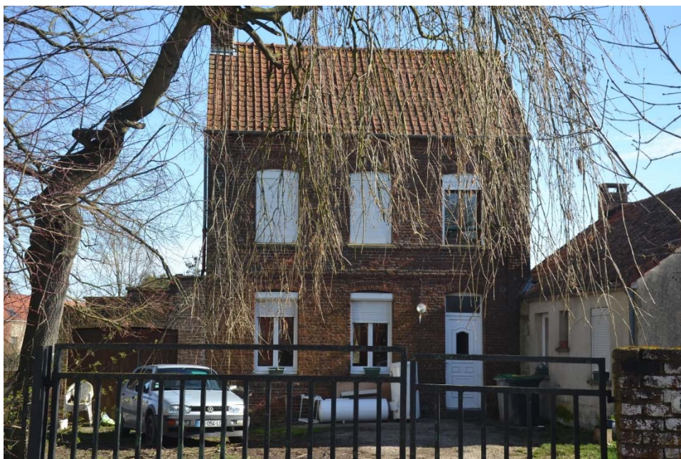
Figure 37 Vue du bâtiment
