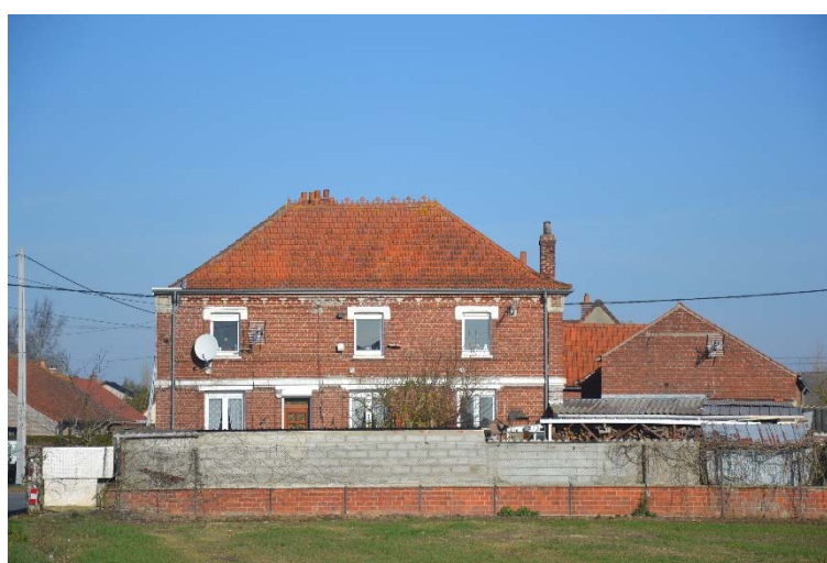
Figure 81 Vue du logis 501 rue du Bibrou
