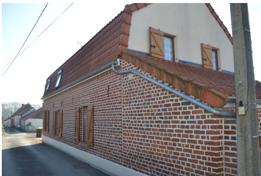
Figure 95 Vue du bâtiment
