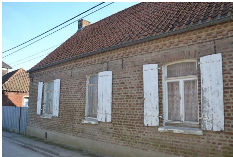
Figure 111 Vue de la façade du logis
