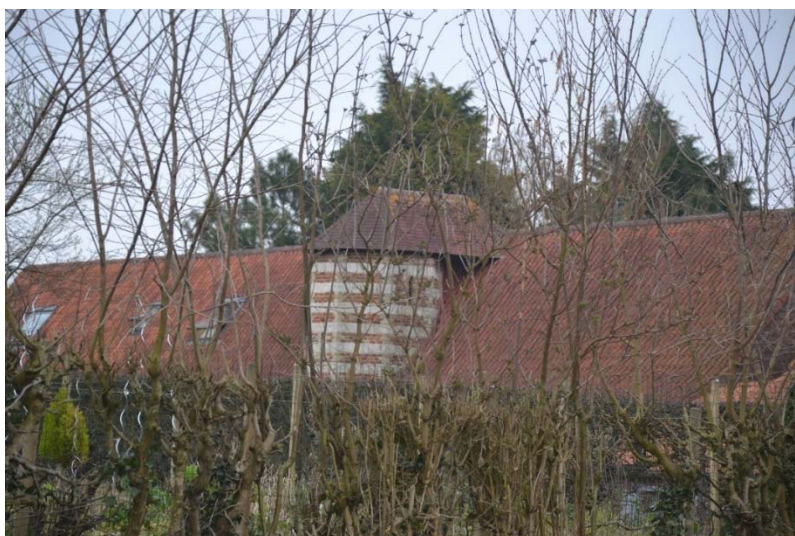
Figure 121 Vue de la tourelle d'escalier (façade arrière)
