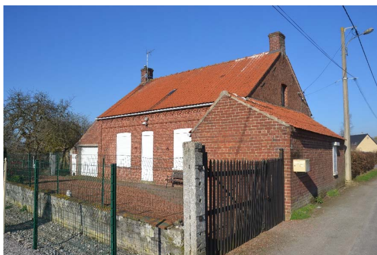
Figure 90 Vue du bâtiment
