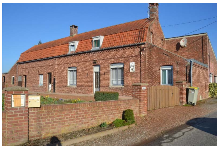
Figure 80 Vue d'ensemble du bâtiment
