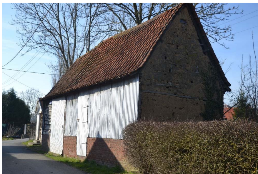
Figure 113 Vue générale de la dépendance
