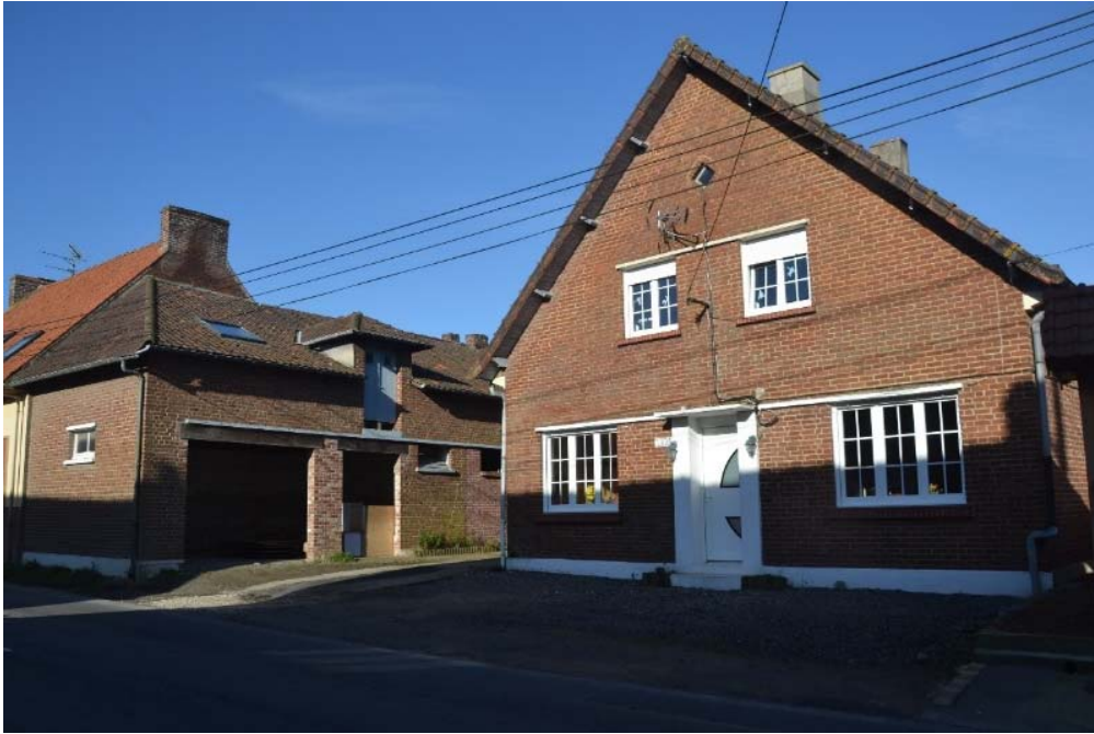
Figure 13 Vue d'ensemble du site
