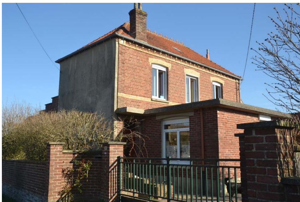
Figure 91 Vue du bâtiment
