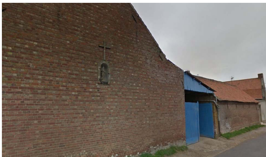
Figure 117 Vue générale du corps de ferme
