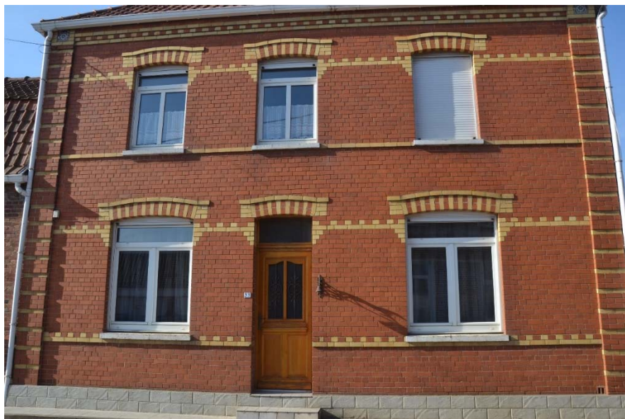
Figure 109 Vue de la façade du logis
