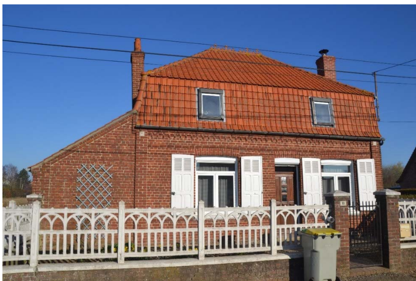
Figure 83 Vue d'ensemble du bâtiment
