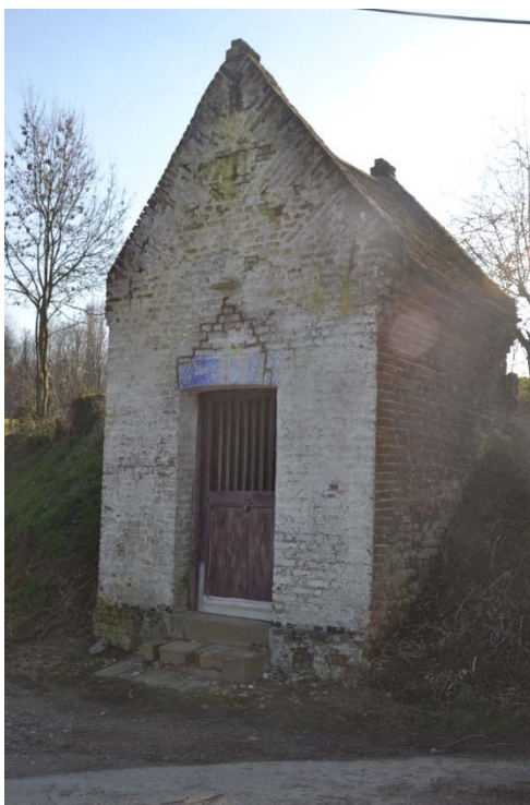
Figure 115 Vue générale de la chapelle
