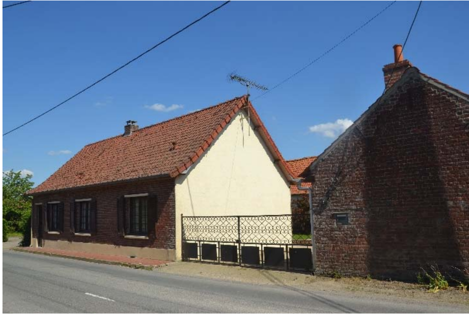
Figure 127 Vue générale du corps de ferme
