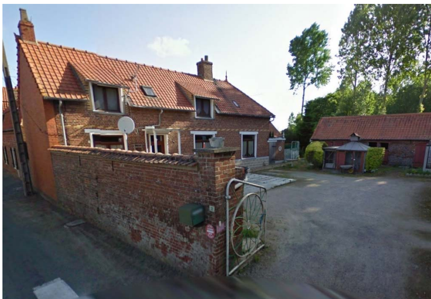
Figure 123 Vue générale du corps de ferme
