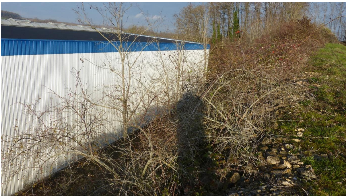
Le talus boisé à l'Est du bâtiment existant sera intégralement préservé, photographie prise le 29.11.2023
