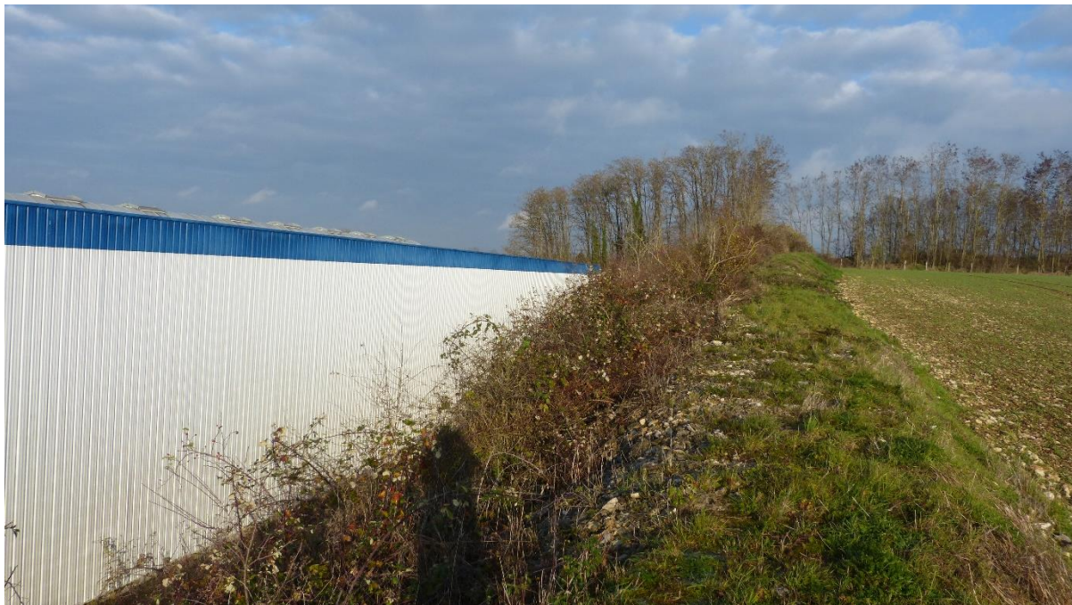
Vue du talus et de la végétation rudérale qu'il abrite. Les buissons y sont composés de ronces communes, de cornouiller sanguin et de sureau blanc.
