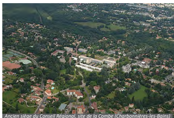
Ancien siège du Conseil Régional, site de la Combe (Charbonnières-les-Bains)
