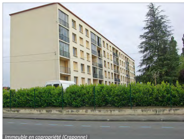
Immeuble en copropriété (Craponne)
