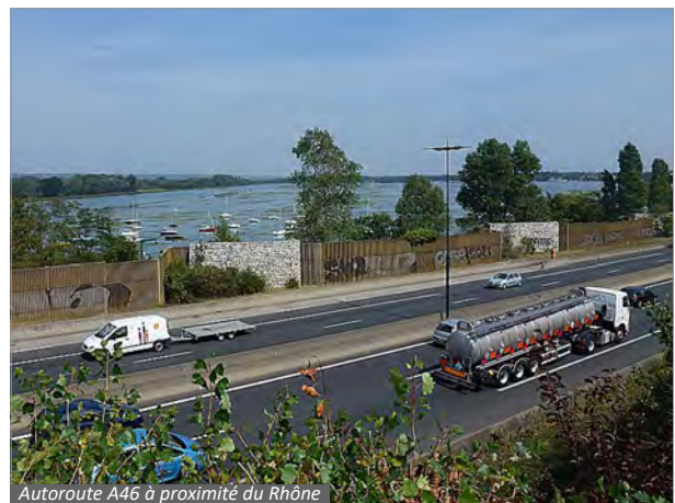
Autoroute A46 à proximité du Rhône
