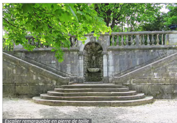
Escalier remarquable en pierre de taille
