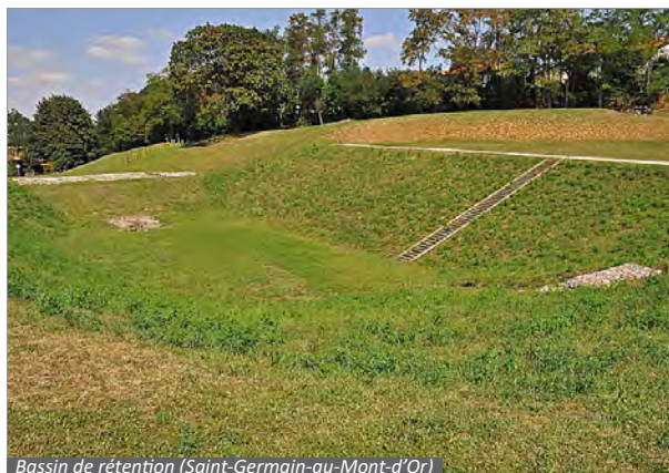
Bassin de rétention (Saint-Germain-au-Mont-d'Or)
