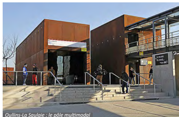
Oullins-La Saulaie : le pôle multimodal
