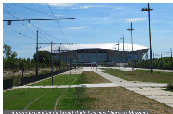
... et après le chantier du Grand Stade (Décines-Charpieu-Meyzieu)
