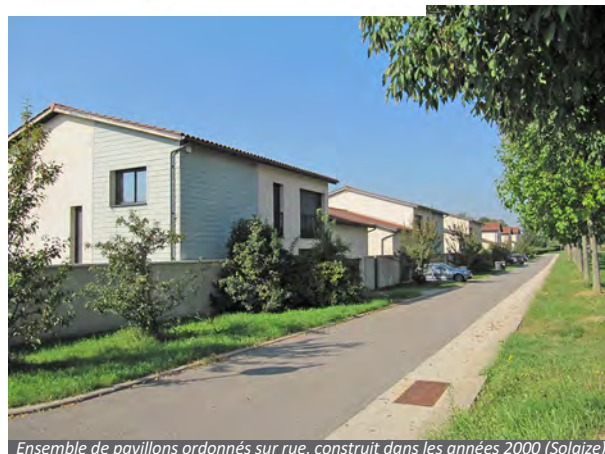
Ensemble de pavillons ordonnés sur rue, construit dans les années 2000 (Solaize)
