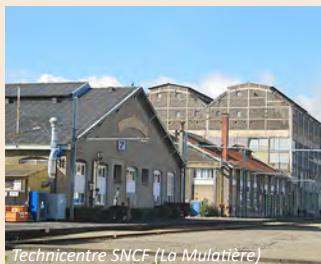
Technicentre SNCF (La Mulatière)
