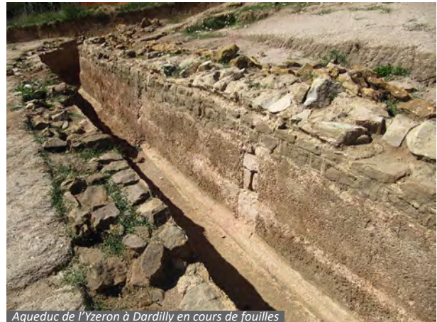
Aqueduc de l'Yzeron à Dardilly en cours de fouilles
