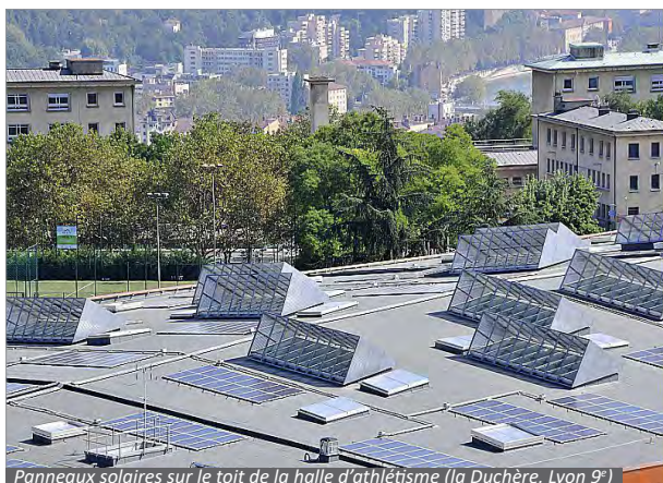
Panneaux solaires sur le toit de la halle d'athlétisme (la Duchère, Lyon 9°)
