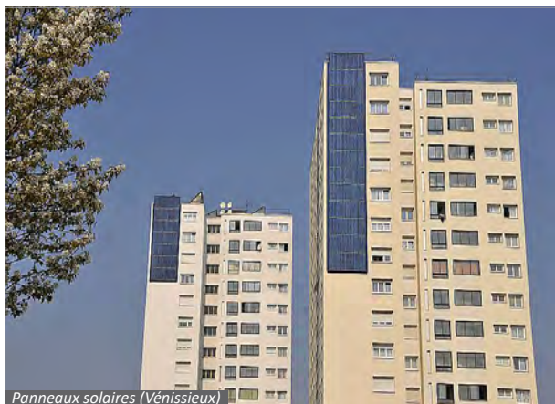
Panneaux solaires (Vénissieux)
