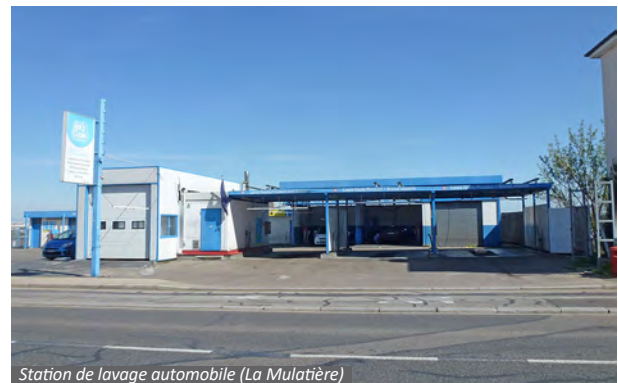
Station de lavage automobile (La Mulatière)
