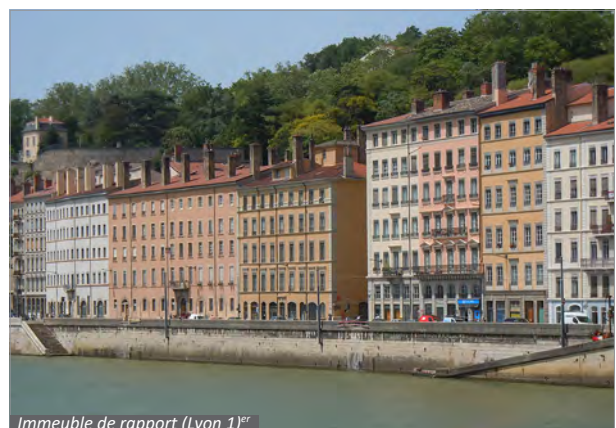
Immeuble de rapport (Lyon 1 er )
