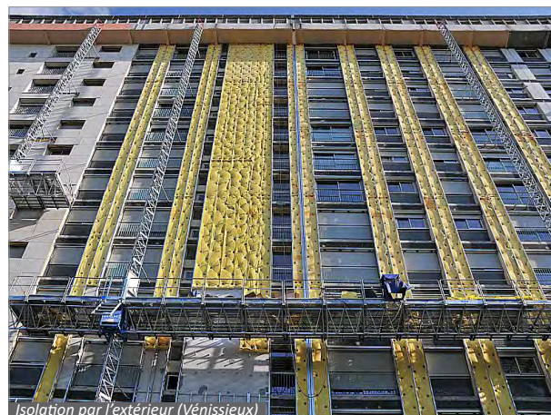
Isolation par l'extérieur (Vénissieux)
