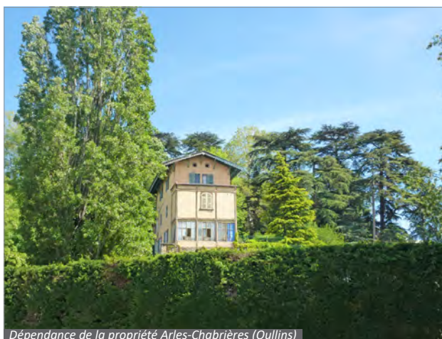
Dépendance de la propriété Arles-Chabrières (Oullins)
