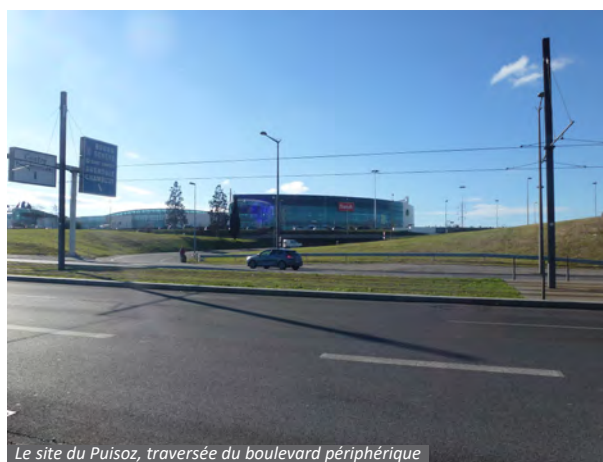
Le site du Puisoz, traversée du boulevard périphérique
