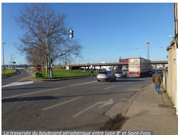
La traversée du boulevard périphérique entre Lyon 8 e et Saint-Fons
