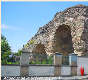
Aqueduc de la Brévenne (Lyon)
