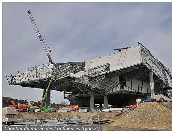
Chantier du musée des Confluences (Lyon 2e)
