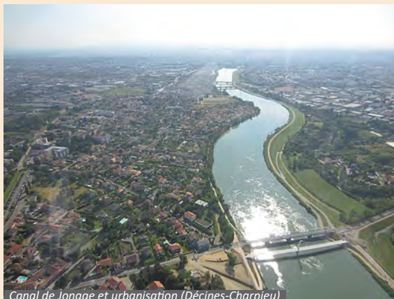
Canal de Jonage et urbanisation (Décines-Charpieu)
