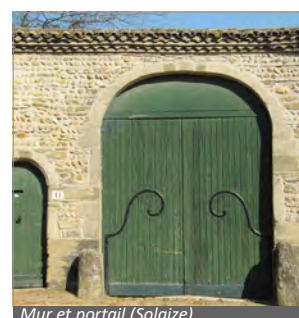
Mur et portail (Solaize)
