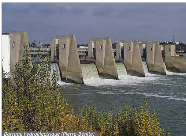
Barrage hydroélectrique (Pierre-Bénite)
