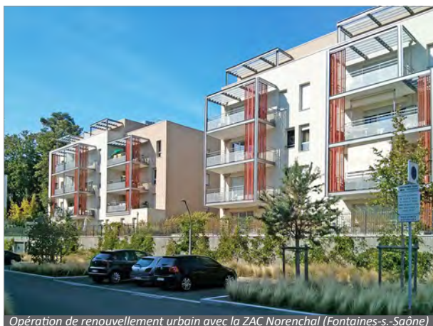
Opération de renouvellement urbain avec la ZAC Norechal (Fontaines-s.-Saône)
