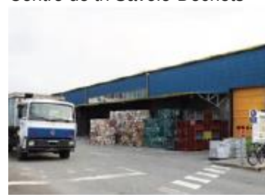
Centre de tri Savoie-Déchets
