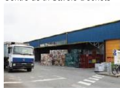
Centre de tri Savoie-Déchets
