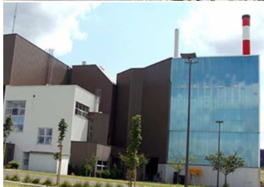
En haut : unité de broyage du bois et des encombrants de Pontarlier En bas : incinérateur de Pontarlier et valorisation énergétique (photo Préval)
