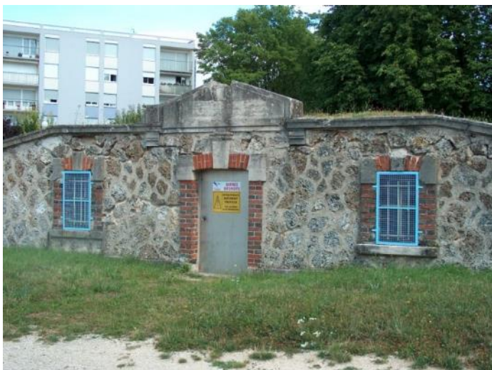
Réservoir des Pavements
