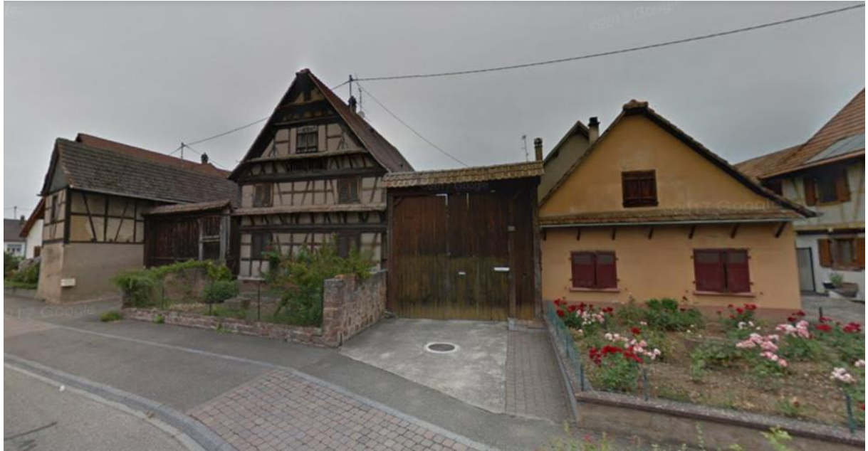
Ferme à Valff. Photo Google Streetview
