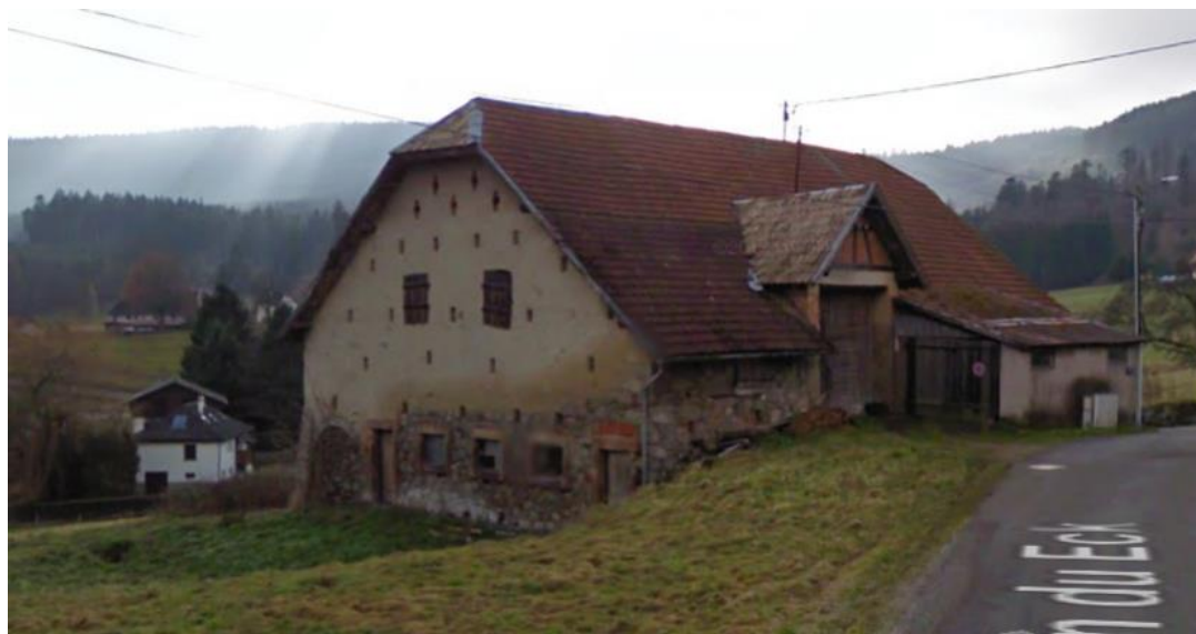
Ferme vosgienne, Le Hohwald. Photo Google Streetview
