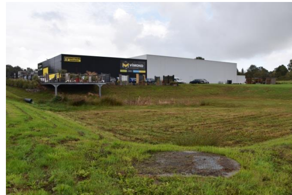
Un bassin de rétention aménagé à proximité de l'entreprise Vimond Matériaux
