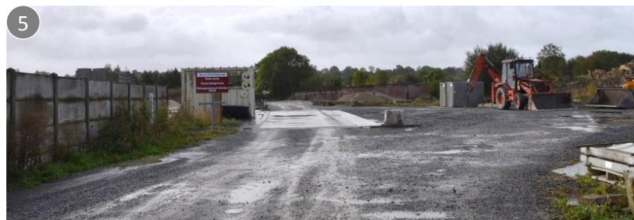
Risque de pollution par infiltration au niveau des espaces de stockage à ciel ouvert
