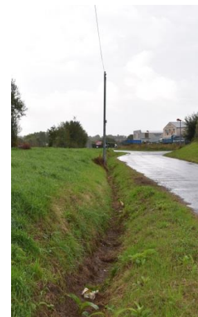
Des noues aménagées le long de la RD971 et du chemin de l'école
