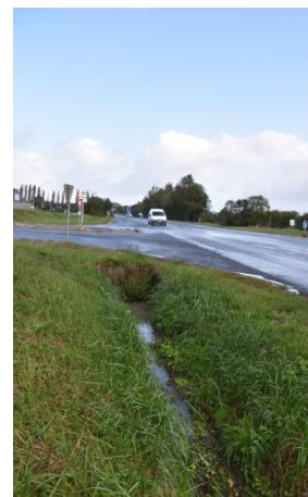
Des noues aménagées le long de la RD971 et du chemin de l'école
