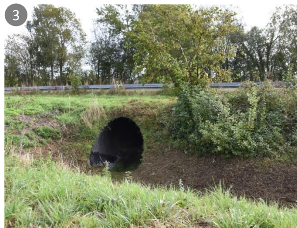
Passage sous la RD971
