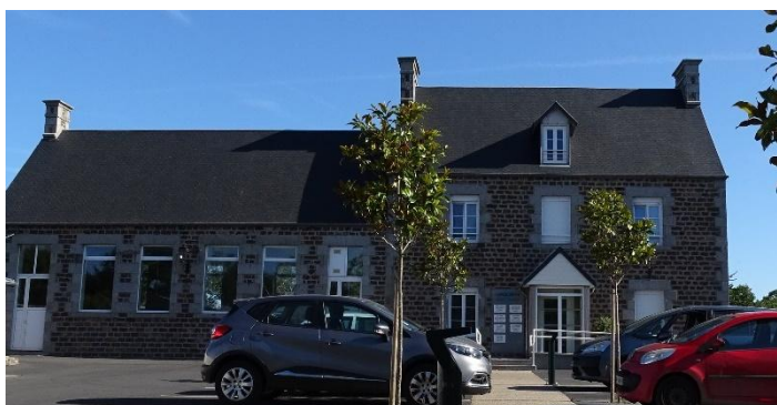
Figure 138 : espace santé à Hudimesnil – Géostudio/2AD
