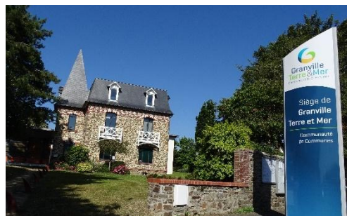
Figure 133 : siège de GTM – Géostudio/2AD
