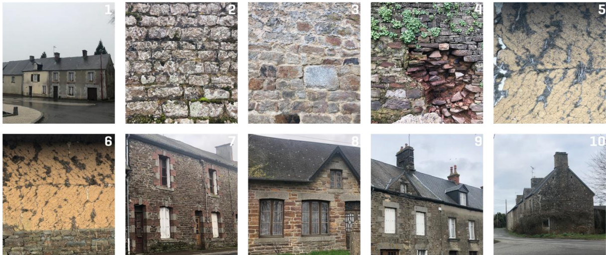
Figure 70 : un bâtiment en R+1 à Chanteloup, des moellons en pierre à Saint-Pierre-Langers et La Meurdraquière, des masses et gazons d'argile à La Meurdraquière, des encadrements d'ouverture en pierre et brique à Folligny, un toit en ardoise à Le Loreur, des lucarnes à Folligny, et une souche de cheminée à Saint-Pierre-Langers.
