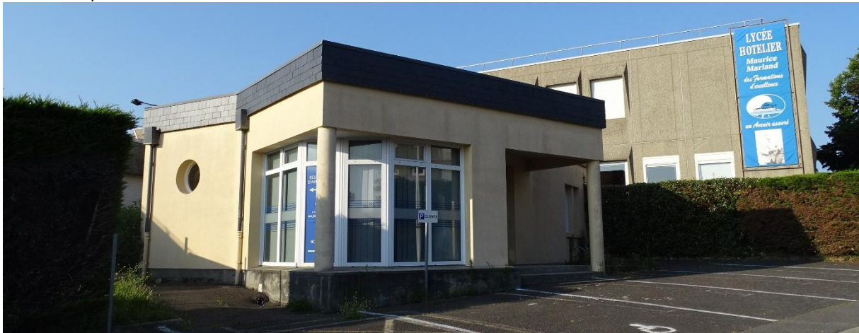
Figure 141 : lycée Maurice Marland à Granville
