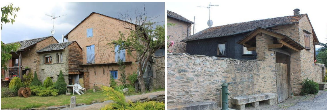
Figure 34 : Réhabilitation d'une petite ferme sur cour en groupement d'habitations, à Palau de Cerdagne
