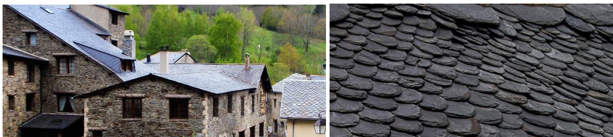
Figure 82 : Les toitures sombres de llose à Valcebollère
