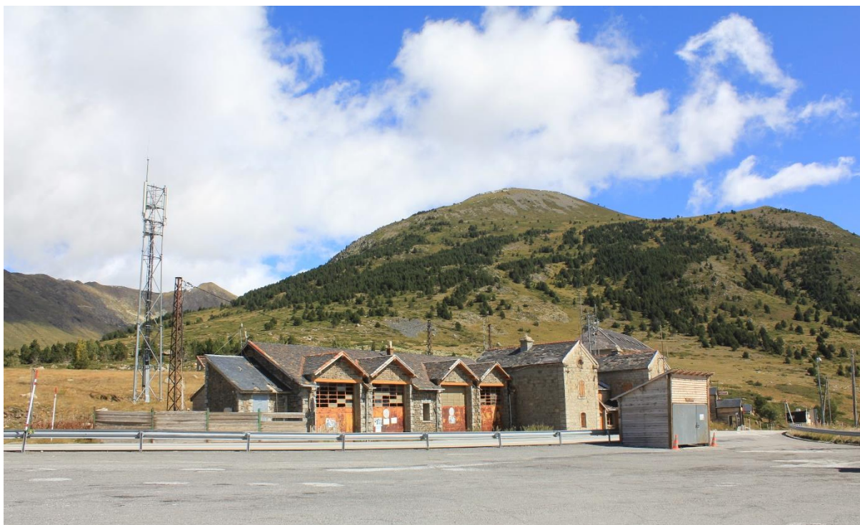
Figure 58 : Site inscrit du Col de Puymorens, bâtiment abandonné et dans un état de dégradation fort et impact visuel du réseau électrique
