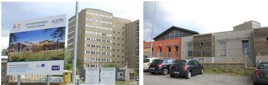
Figure 47 : De gauche à droite : Bâtiment La Perle à démolir et les nouvelles constructions du centre de santé (commune d'Osséja)
