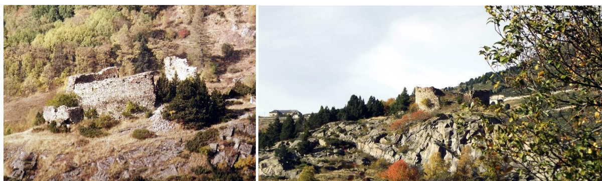
Figure 61 : Ruines de la Tour Cerdane, commune de Porté Puymorens. Source : Jean RIBOT
