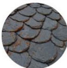
TOITURE EN LLOSE
