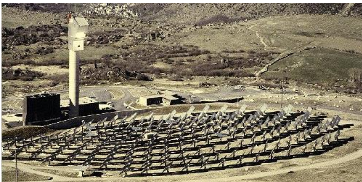
Figure 80 : La centrale Thémis, dans les années 90, source : http://www.cestenfrance.fr/centrale-themis/
