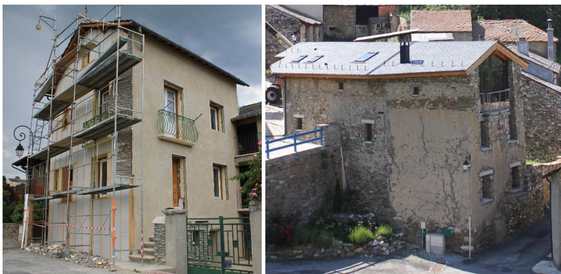
Figure 57 : De gauche à droite : Réhabilitation à Palau de Cerdagne / Réhabilitation dans la commune de Llo
