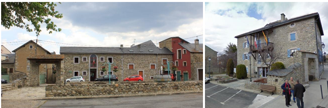
Figure 33 : Équipement aménagé dans une ancienne ferme close en cœur de Bourg Madame et Mairie d'Osséja dans une ancienne maison bourgeoise-ferme sur cour
