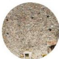
MUR DE GRANITE
