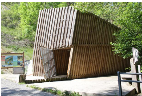
Figure 80 : Local d'accueil de la Via ferrata de Llo
