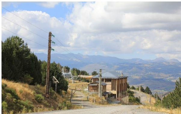
Figure 76 - Les bâtiments de Cerdagne-Puigmal-2900
