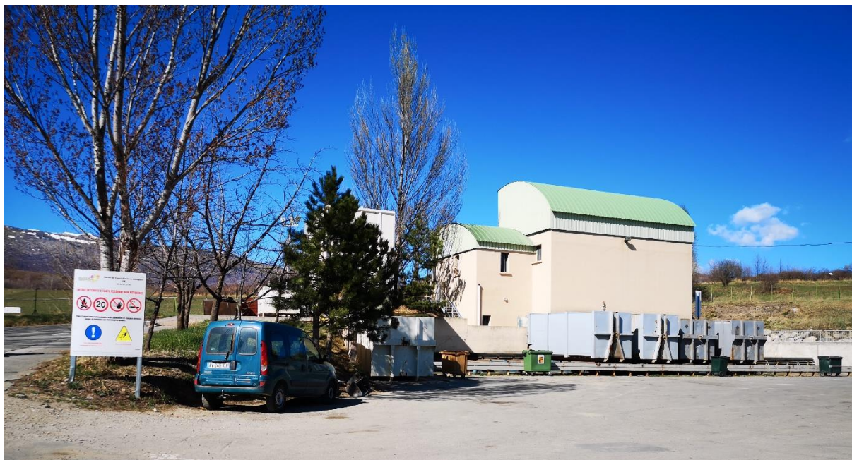
Figure 12 : Photographie : Quai de transfert des déchets ménagers à Ur
