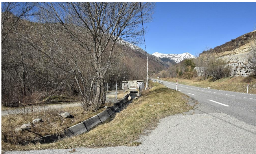
Figure 8 : Photographie : Prise d'eau du Canal de Puigcerdà
