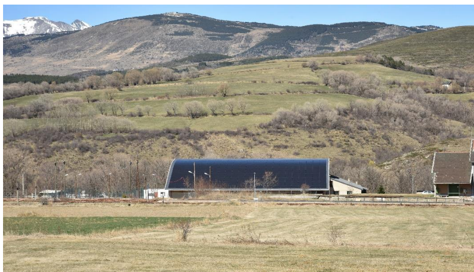
Figure 11 : Photographie : Toiture photovoltaïque sur équipement public à Saillagouse
