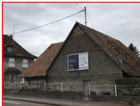
publicité sur façade (hauteur > égout du toit)
