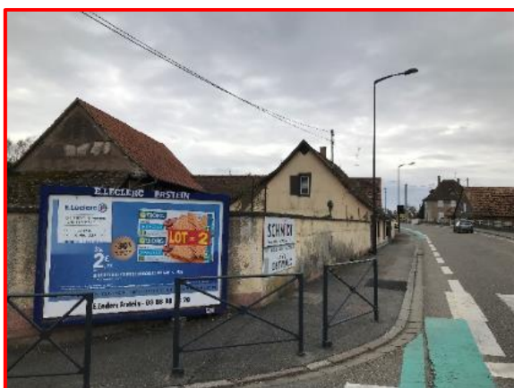
publicité sur clôture (hauteur < 0,50 m, dépassement)
