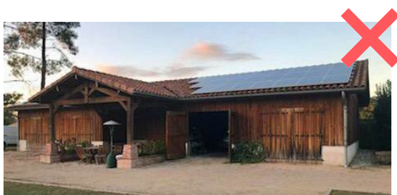
Mise en œuvre de panneaux photovoltaïques en toiture en « escaliers » : à éviter
