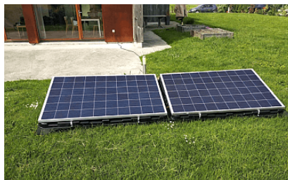
Mise en œuvre correcte de panneaux photovoltaïques au sol
