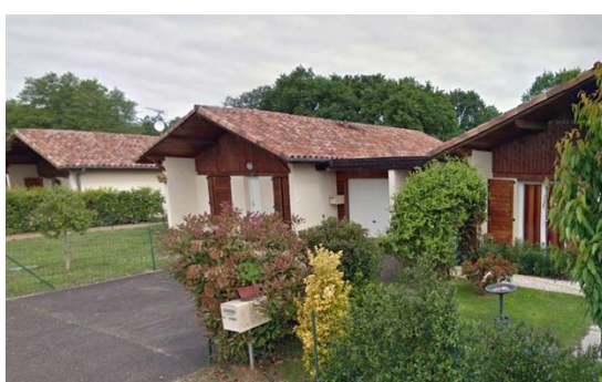
Sabres - Impasse de l'Isle - Construction 2005
