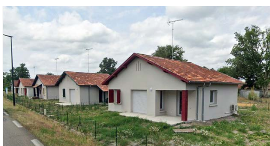
Moustey - Garaude - Construction 1956, réhabilités
