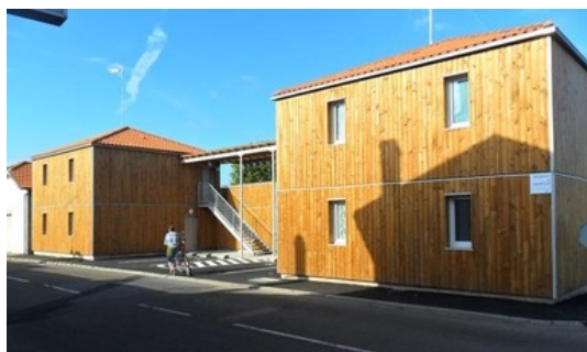
Résidence Le Fronton, Labouheyre Construction 2011
