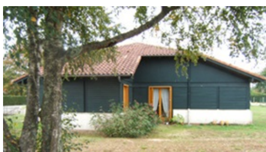
Le Sen - Résidence Le Bourg - Construction 1982, réhabilités
