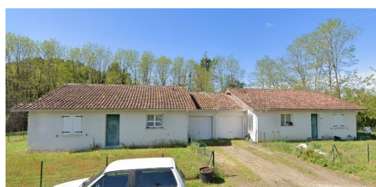
Argelouse - Bourg Construction 2009
