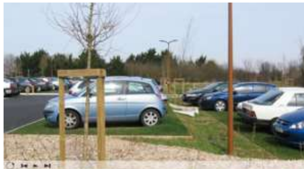
PARKING VEGETALISÉ AVEC DALLE GAZON ECOVEGETAL GREEN
