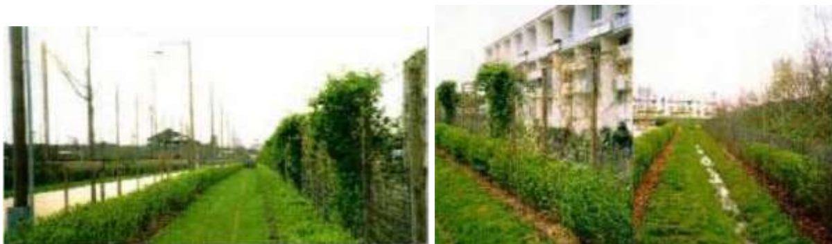
Exemples de fossés et de noues en limite séparative, « permettant ainsi de réconcilier des utilisateurs du parc d'activités avec la présence et la vue d'une eau vivante » (Source des photos : Paysage régulation et gestion des eaux pluviales – Direction de la Nature et des paysages, Sous-Direction des Sites et Paysages, Bureau des Paysages - Ministère de l'écologie et du développement durable)
