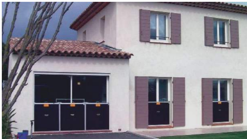
Exemple de protections des ouvertures
