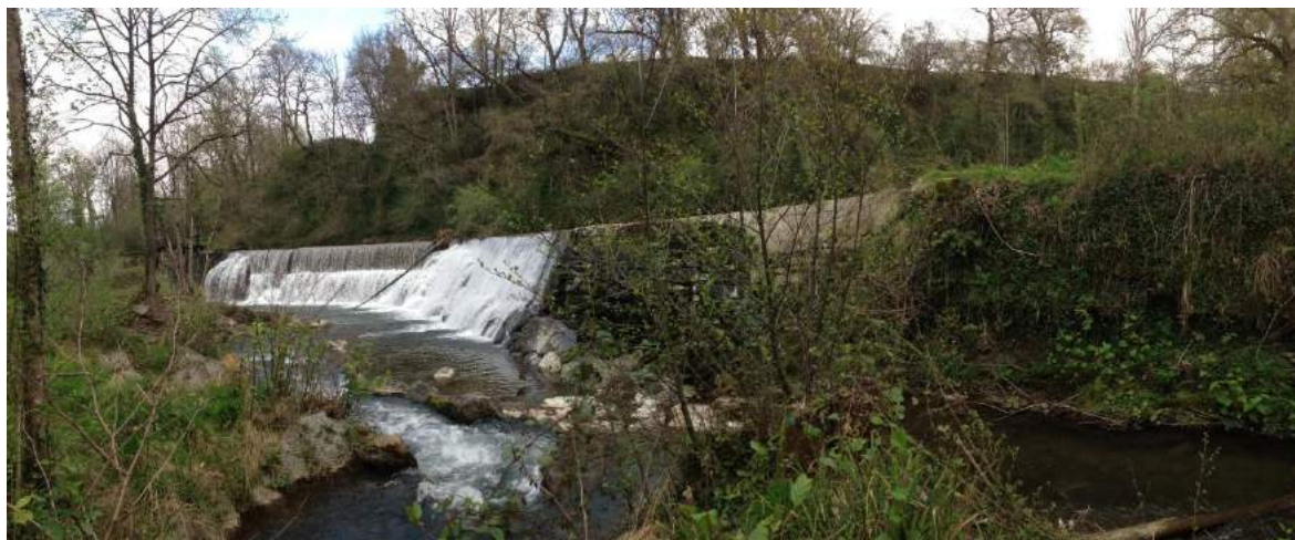
Fig. 33. Seuil d'alimentation de la centrale électrique Bessonneau
