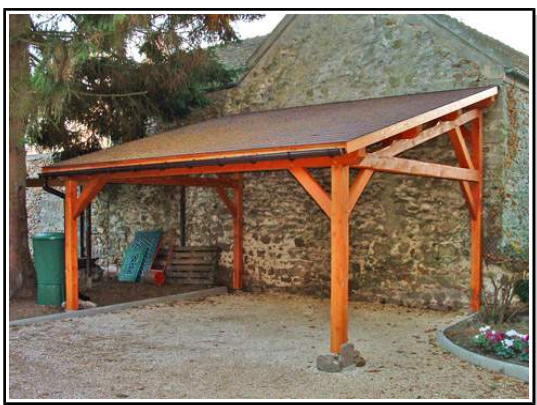
Construction annexe adossée à façade
