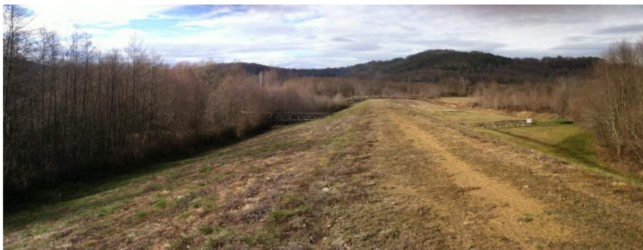
Fig. 10. Barrage écrêteur de crues des Mielles
