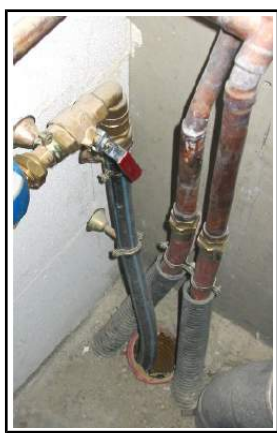
Exemple d'entrées de réseaux à calfeutrer
