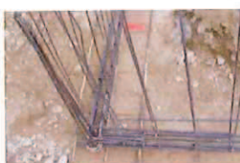
Nœud de chaînage - Continuité mécanique
