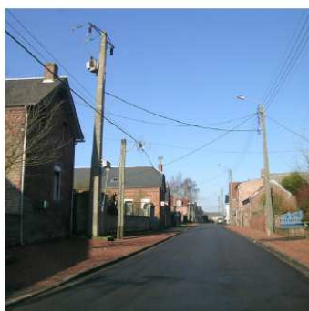
Le bâti à mi-versant
