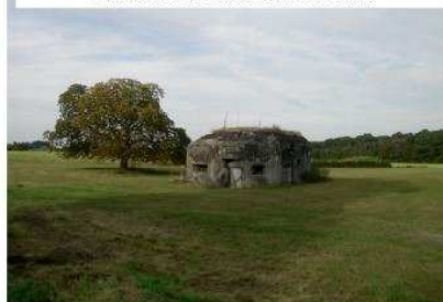
Casemate à Taisnières-sur-Hon
