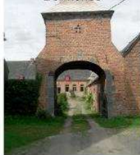
Pigeonnier porche à Bermeries
