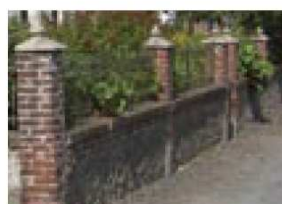
Muret surmonté d'une grille.
