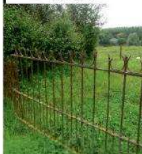
Barrière métallique au Favril
