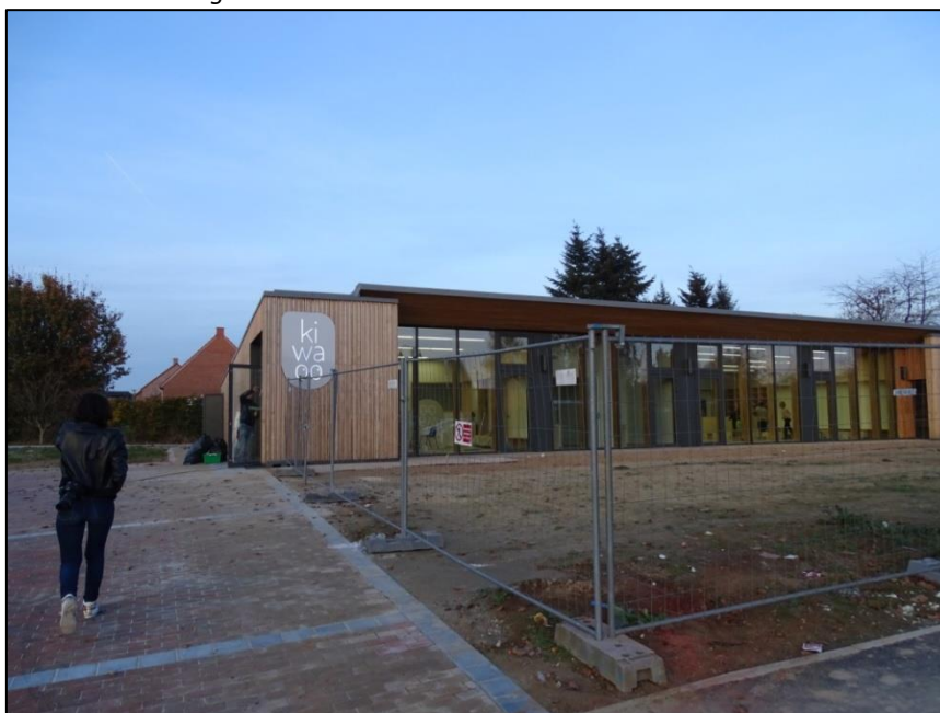
Figure 7 : Construction de la crèche sur Villereau.
