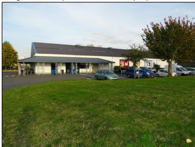
Figure 12 : Le supermarché Lidl à Bavay depuis la D649.
