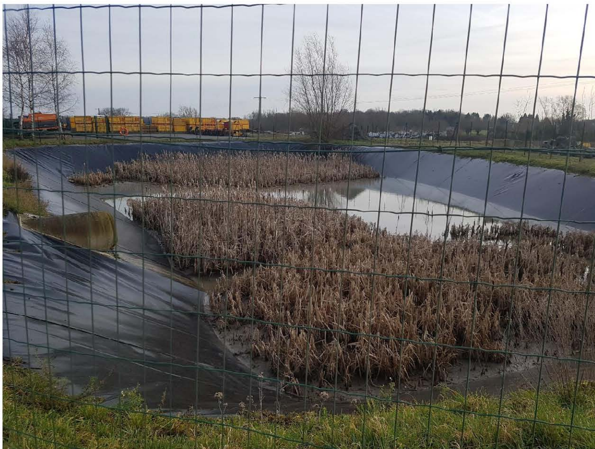
Figure 12: Photographie d'une zone de rétention d'eau
