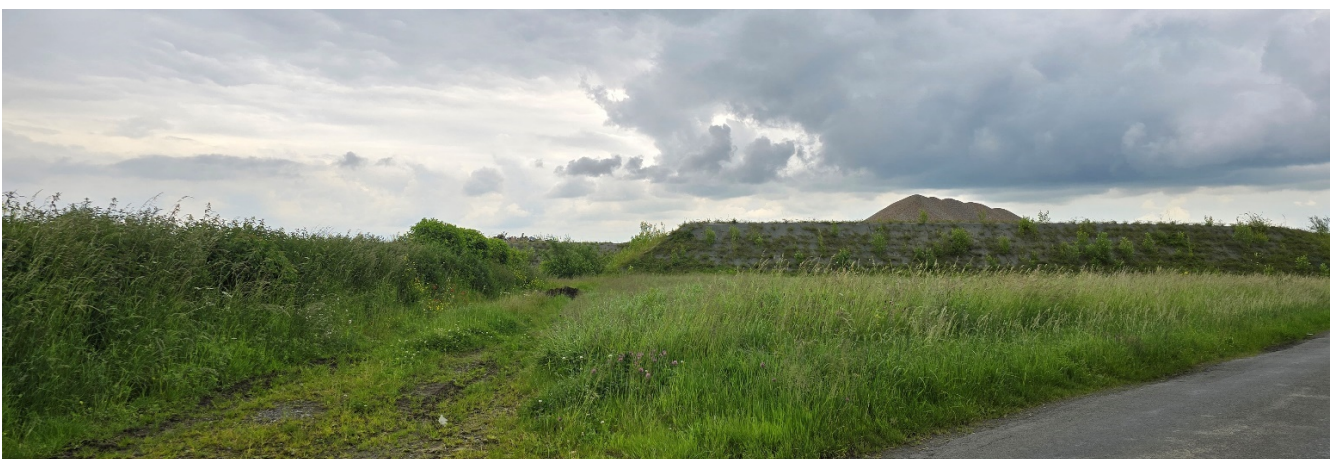
Vue 2 depuis l'Ouest sur la RD95
