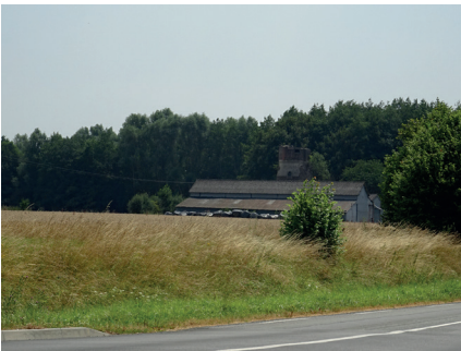
La ferme Richard et la tour ruinée d'un ancien moulin à vent (Houdain-lez-bavay)
