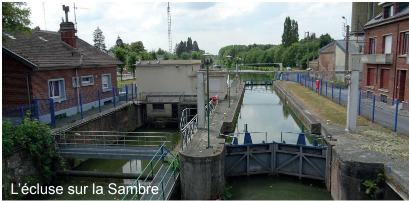
L'écluse sur la Sambre
