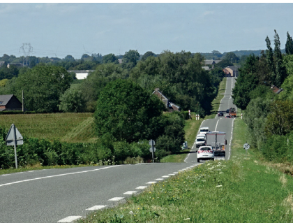
L'ondulation de la route au niveau de la ferme du Verger Pilote (Maroilles)
