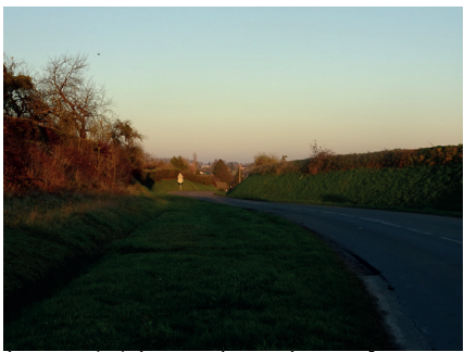
Imposants talus au niveau du carrefour formé par le chemin de Villers-Pol et la route de Le Quesnoy
