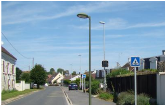
Rue du Pont des Planches (RD146)
