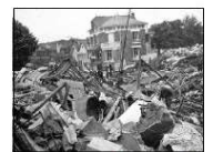
Effondrement généralisé 1 er juin 1961 à Clamart (idem rue Ernest Renan à Achicourt le 12 mai 1925 - diamètre 50 m - 4 à 14 rue de Bapaume)
