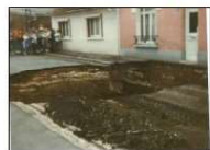
Effondrement d'intensité élevée (> 20 m) à Beaurains le 13 juin 1997
