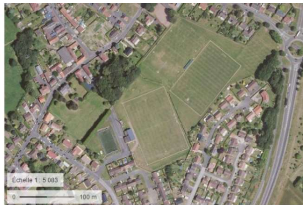
Photographie aérienne actuelle du site – Source : IGN
