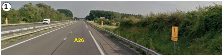
Vue depuis l'A26 au nord - le talus et la végétation empêchent les vues. Toutefois, ces derniers ne sont pas toujours présents et permettent ponctuellement certaines vues vers la zone de projet
