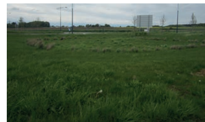
L'espace de gestion hydraulique
