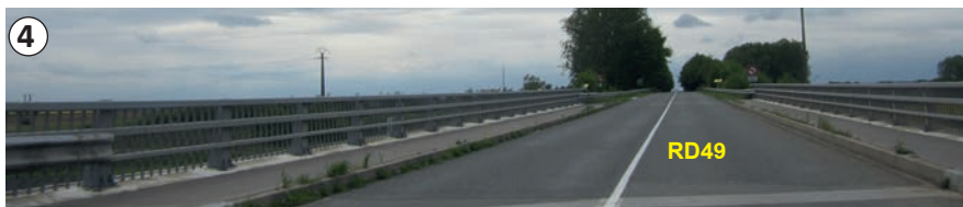
Vue depuis la RD49 à l'est - la végétation empêche les vues. Les vues éloignées depuis cet axe sont impossibles
