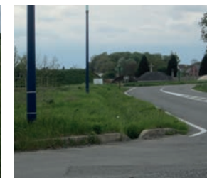
La noue le long de la RD49
