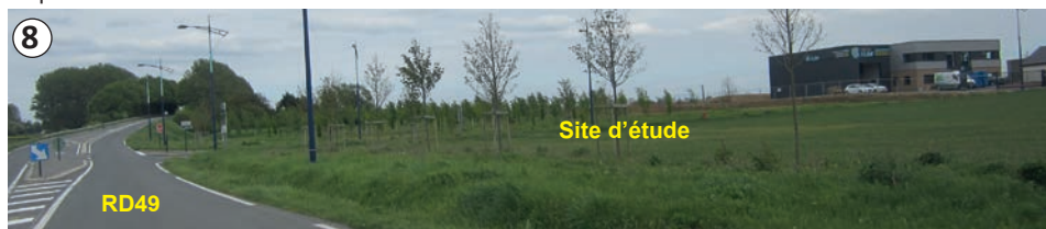
Vue depuis la RD49 au nord de la zone - le site est ouvert aux vues. Lorsque le traitement végétal sera mûre, les vues seront plus cadrées, plus vertes depuis ce point
