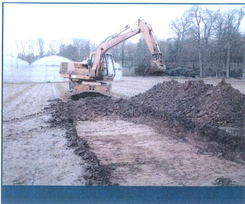
Photo 2 : Début du décapage
