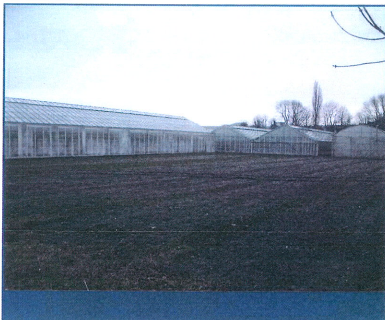
Photo 1 : Zone d'étude avant décapage
