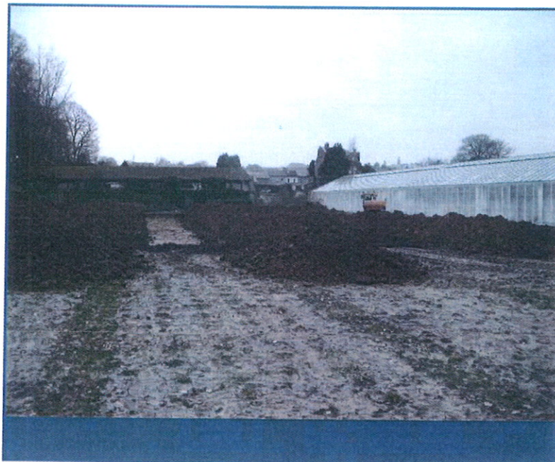
Photo 3 : Décapage de la zone
