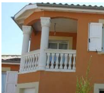
Type de balustres interdites
