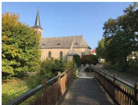
DENTING – PASSERELLE DU RUISSEAU DU MUEHLENBACH
