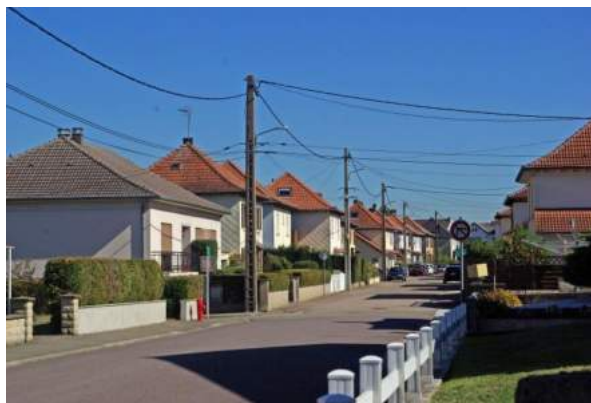
FALCK – CITÉS OUVRIÈRES QUI SE DÉGRADENT
