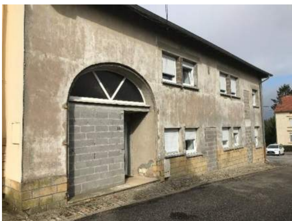
TROMBORN – PORTE DE GRANGE MURÉE POUR CRÉER UNE PORTE D'ENTRÉE
