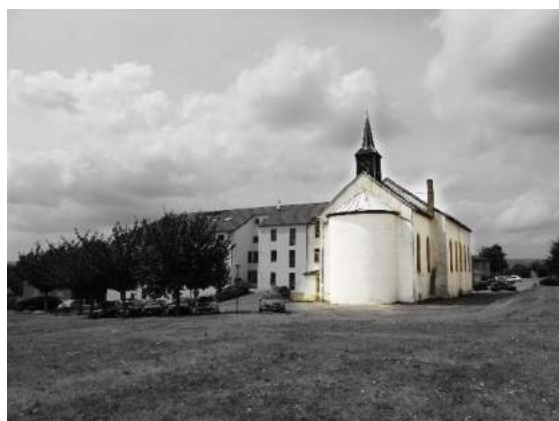
TÉTÉRCHE – ANCIEN COUVEN ET CHAPELLE DE RÉDEMPTORISTES
