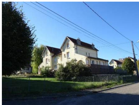
BOCKANGE – LES BÂTIMENTS DE LA CITÉ CONSERVÉS
