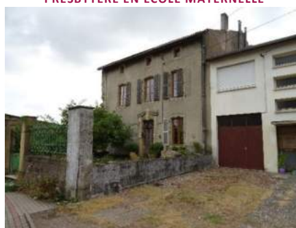
OTTONVILLE – RECONVERSION DU PRESBYTÈRE EN MAISON INDIVIDUELLE
