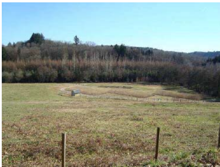
Vue de la station d'épuration en aval du bourg
