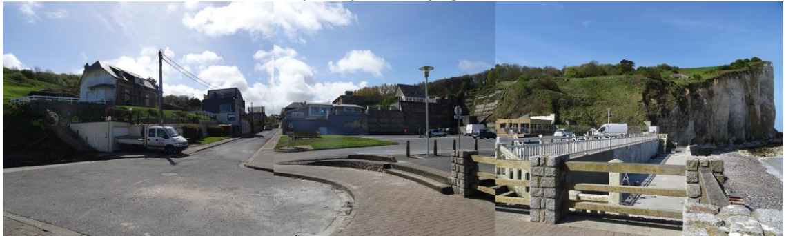
Panoramique depuis la limite de la plage vers l'ouest et le sud
