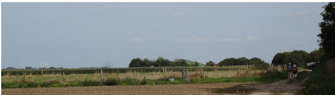
Vue de l'exploitation JOLLY depuis le chemin d'exploitation utilisé par le GR21
