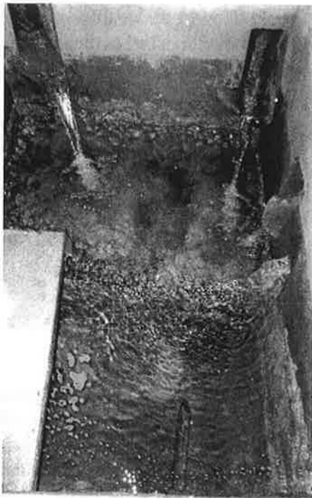
Photographie 2 : Arrivée des trois drains dans la chambre de réception. Photographie 3 : Tuyau crépiné et trop plein du bac de départ
