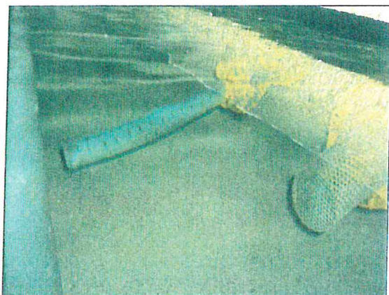
Clichés 20 & 21 : crépine sur les départs et bonde de trop plein/vidange
