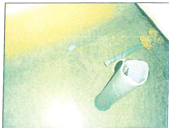
Clichés 20 & 21 : crépine sur les départs et bonde de trop plein/vidange
