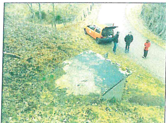
Clichés 15 & 16 : le bassin de réception/décantation du captage de Bégue Haut
