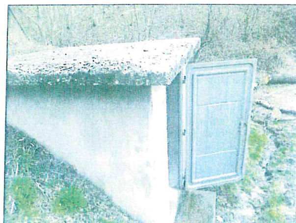
Clichés 25 & 26 : présence d'écoulements devant la porte du captage de Bégué Haut
