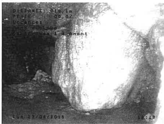
Photographie n° 4 : Vue du fond d'un épi ou du drain n°1, par inspection télévisuelle.
