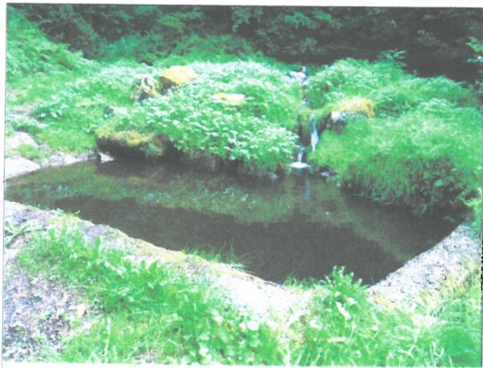
Prise d'eau et bassin de décantation
