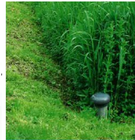
Lagunage par filtres à roseaux : l'eau usée coule dans un 1 er bassin planté de roseaux, puis un 2 ème .
