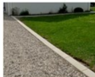
Allée gravillonnée qui permet l'infiltration des eaux pluviales
