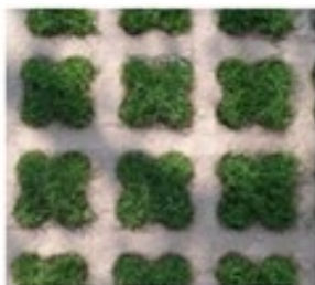
Allée béton alvéolé : perméabilité et durabilité.
