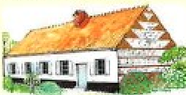
Maçonnerie de craie
