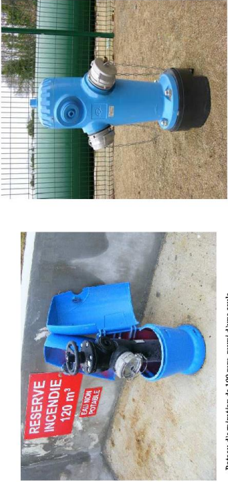
Poteau d'aspiration de 150 mm, muni de deux sorties de 100 mm et d'un carré de manœuvre
