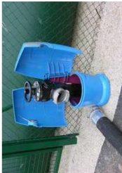
Poteau d'aspiration de 100 mm
