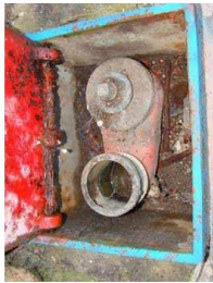
Bouche Incendie de 80 mm à raccord Keyser
