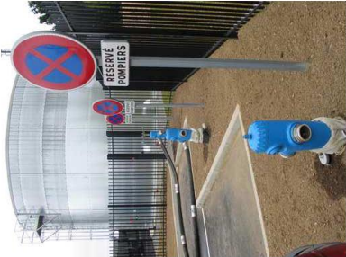
Reserve d'eau incendie aérienne de 720 m³ équipée de 3 poteaux d'aspiration de 150 mm.
