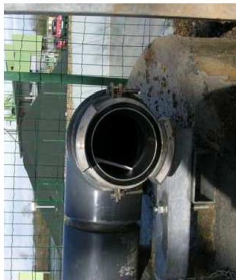
Une sortie de 100 mm avec les tenons verticaux (l'un au dessus de l'autre)
