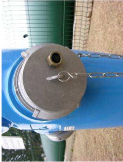
Poteau d'aspiration de 150 mm muni d'un Airclap
