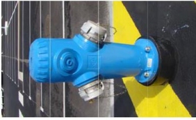
Poteau d'aspiration à réseau sec de 150 mm, muni de deux sorties de 100 mm et d'un Airclap. Pas de carré ni de volant de manœuvre
