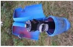
Poteaux d'aspiration de 100 mm à réseau sec, munis d'une seule sortie de 100 mm Pas de volant ni de carré de manœuvre.
