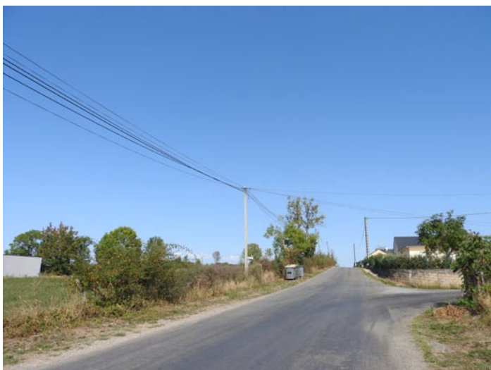
Vue depuis la voie existante au Sud-Est
