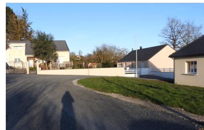
EXEMPLE DE CONSTRUCTIONS NEUVES SALMIECH
