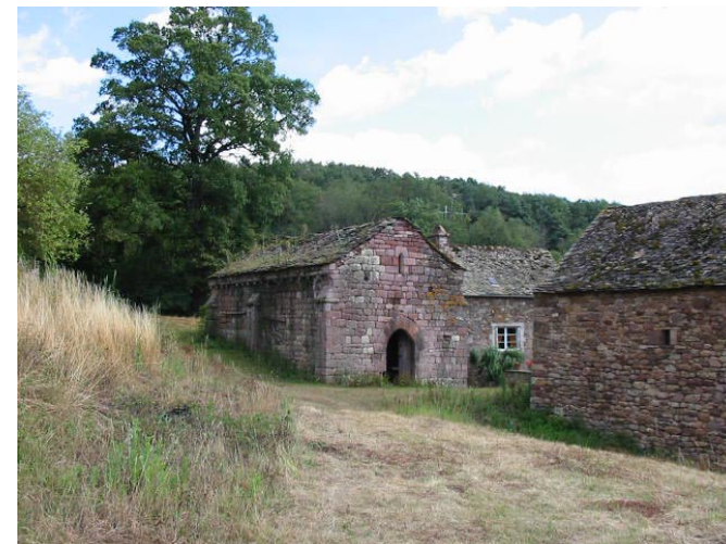
CONSTRUCTIONS ISOLÉES AGEN D'AVEYRON
