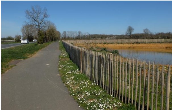
Le bassin de rétention
