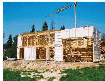
Chantier d'une maison à ossature bois
