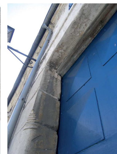
Profils de corniche pierre sur les maisons (chanfrein, moulurée, doucine).
