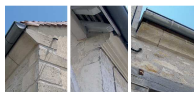
Profils de corniche pierre sur les maisons (chanfrein, moulurée, doucine).
