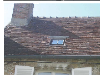
Ruellées, façons et détails de pose de tuiles animent les maisons.
